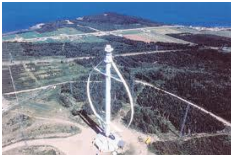
Figura 4.15 Vista panoramica dell'aerogeneratore verticale "Eole", con un rotore di 110 metri (la distanza massima tra le pale, misurata in orizzontale) e una capacità nominale di 3,8 MW.
