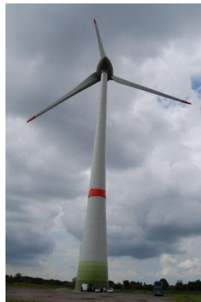
Figura 2.6 Enercon e-126. Il modello di aerogeneratore con potenza nominale maggiore attualmente: 7.58 MW. Ha un rotore di 126 metri di diametro.
