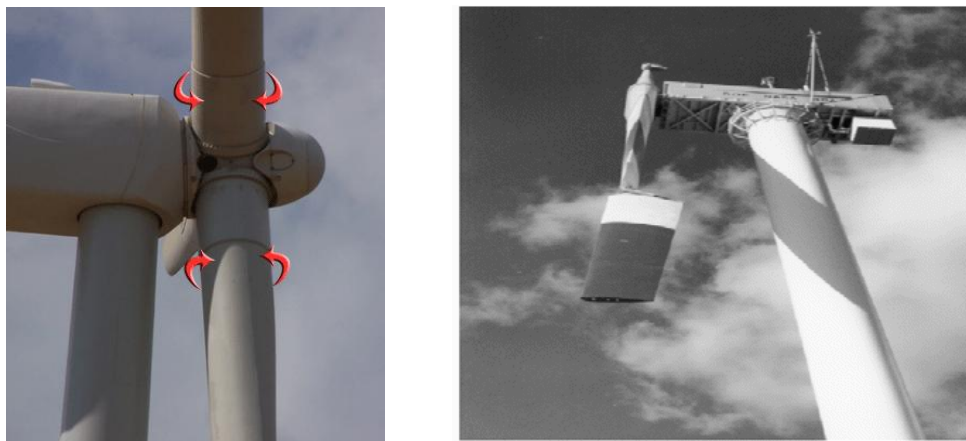
Figura 2.9 A sinistra mediante frecce rosse si mette in evidenza il moto di pitch che consente alle pale di ruotare attorno al proprio asse longitudinale; a destra un esempio di partial span pitch control, con solo la parte esterna della pala libera di ruotare.
