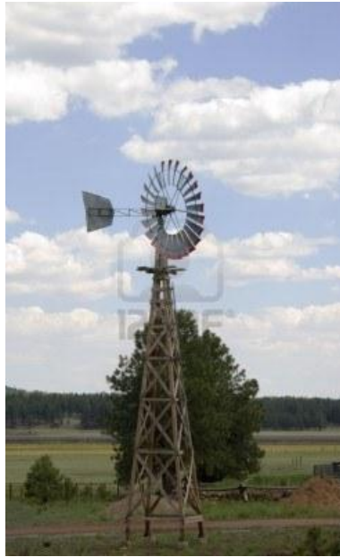
Figura 3.21 Turbina eolica con torre a traliccio in legno.
