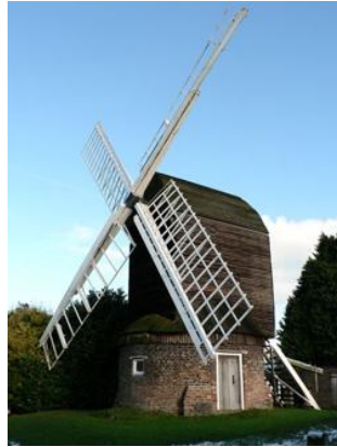
Figura 2.2 Esempio di mulino a vento di tipo “post mill”; si noti il basamento circolare attorno a cui è possibile la rotazione.
