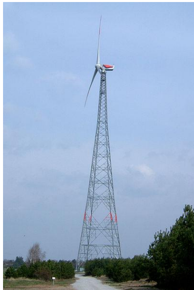
Figura 4.14 Fuhrlaender Wind Turbine FL -2500, Laasow (Germania), con la sua torre a traliccio e un diametro del rotore di 90 metri. Con la sua altezza al mozzo di 160, ha detenuto il record di turbina più alta fino alla fine del 2012, prima che venisse battuta dai due esemplari della stessa azienda con un diametro del rotore maggiore.
