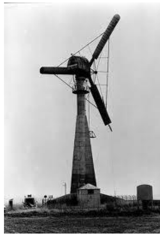
Figura 2.4 Turbina da 200 kW eretta da Johannes Juul a Gedser, Danimarca.
