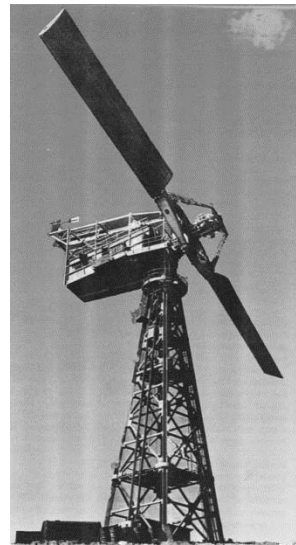
Figura 3.23 A sinistra la turbina anni 50' a Gedser (Danimarca) da 200 kW. A destra la Smith-Putnam da 1.25 MW (anni 40').
