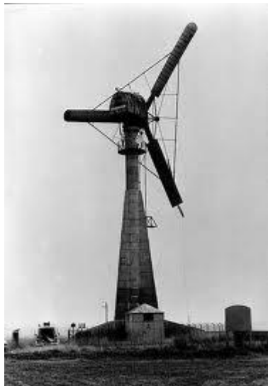
Figura 3.23 A sinistra la turbina anni 50' a Gedser (Danimarca) da 200 kW. A destra la Smith-Putnam da 1.25 MW (anni 40').
