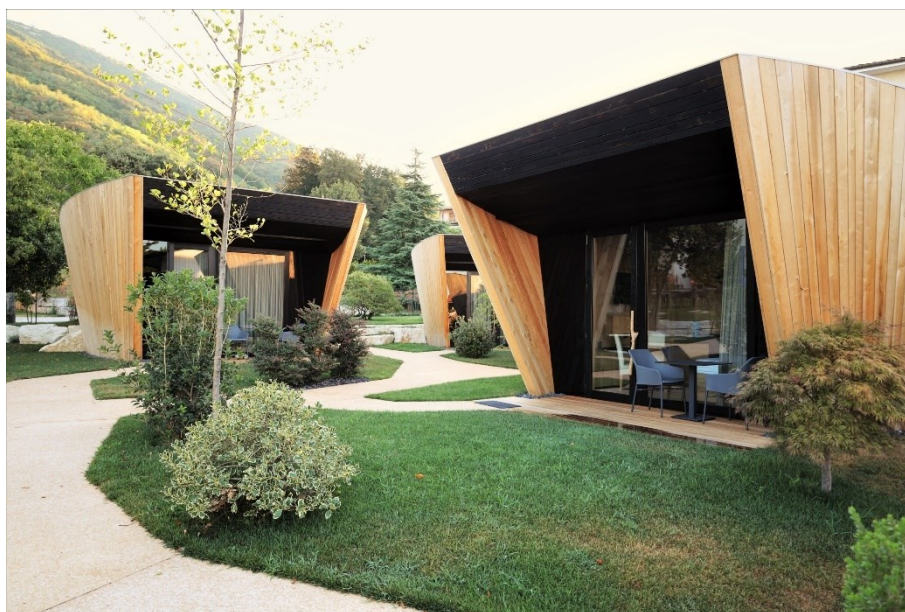
Figura 28: Strutture in legno Roggia dei Cedri
