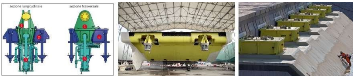
Figura 1.3: A sinistra: componenti del gruppo cerniera-connettore (1.elemento maschio, 2.elemento femmina, 3.aggancio). Al centro: elementi maschi installati alla paratoia. A destra: elementi femmina installati sul cassone di soglia.
