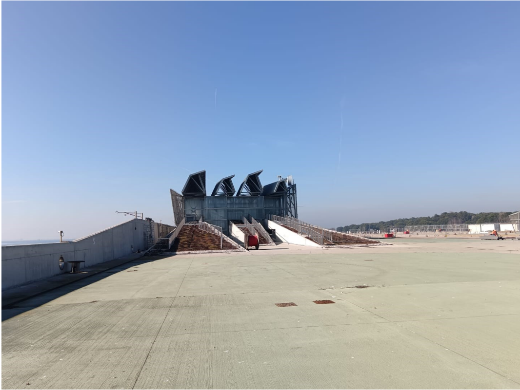
Figura 4.9: Sovrastruttura soprastante il cassone di spalla Nord della Barriera di Chioggia; foto scattata il 2 Febbraio 2024.
