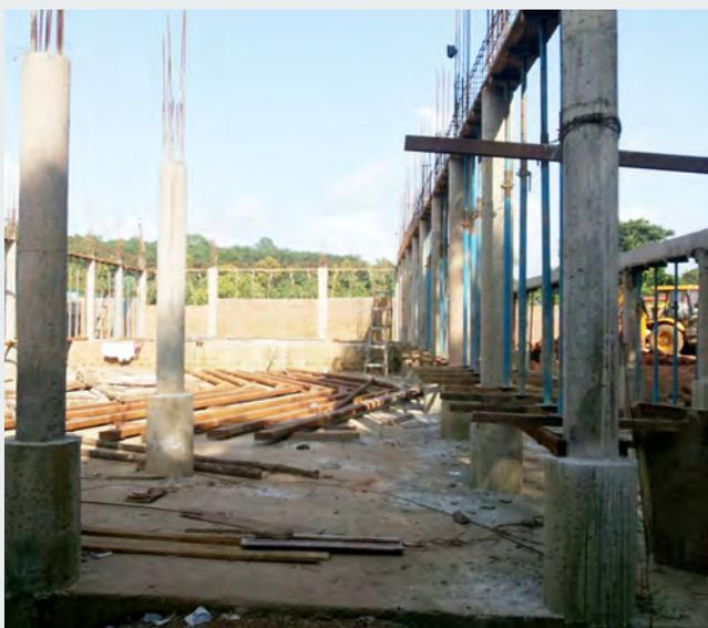
Fasi di getto delle colonne e delle travi
