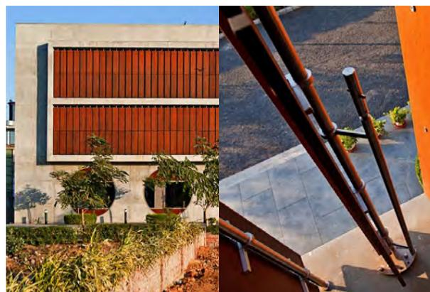
Pannelli verticali incernierati centralmente tramite un perno
