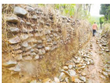
Muro di contenimento costruito in ciotoli di fiume e terra
