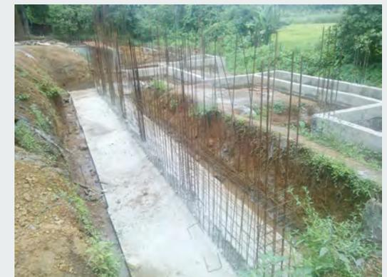
Posatura e getto delle fondazioni e del muro di contenimento - casseri e richiami delle armature
