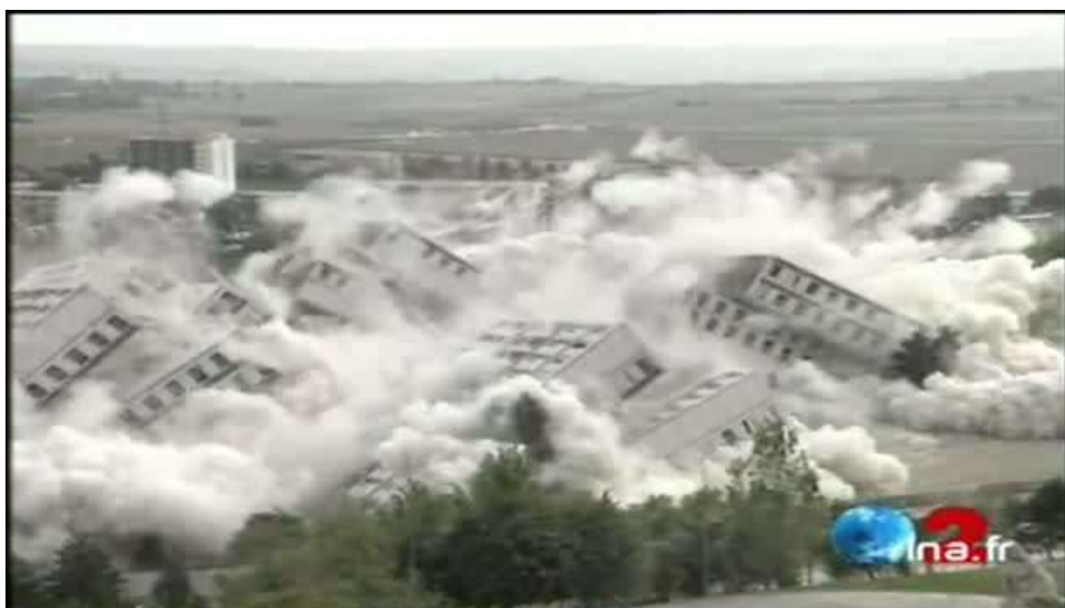
Fig. 17 : Démolition des tours du quartier Démocratie dans la cité des Minguettes, à Vénissieux, en 1994. (Image tirée de http://www.ina.fr/video/CAB94097384 ).
