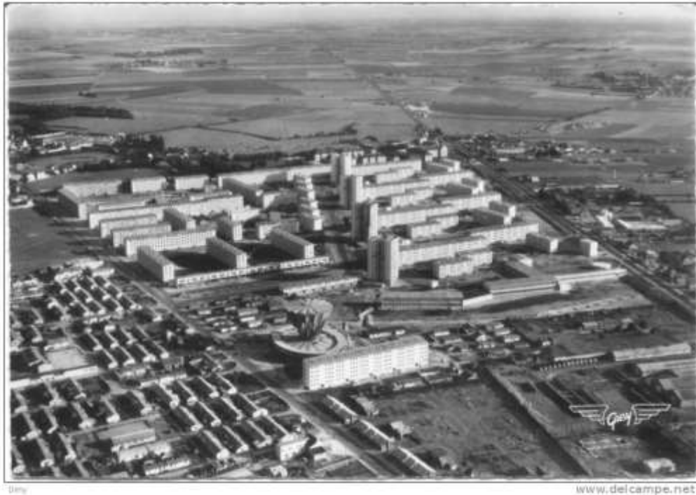
Fig. 4 : Vue aérienne du quartier de la Guérinière à Caen dans les années 1960 (Image tirée de http://il-etait-ifois.eklablog.com/un-aerodrome-au-sud-de-caen-a107811232 ).
