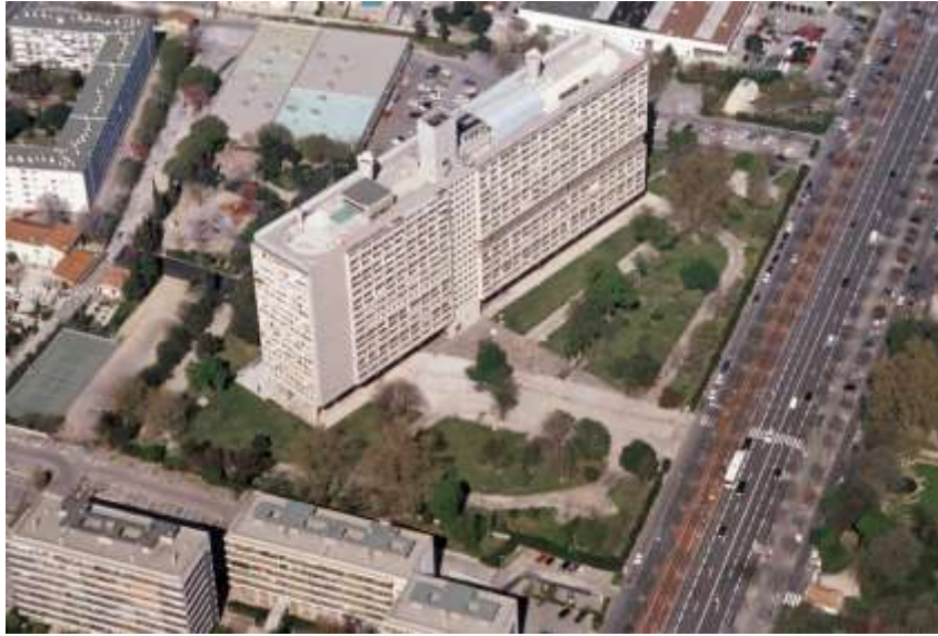
Fig. 2 : Unité d'habitation Le Corbusier dite Cité Radieuse à Marseille (Image tirée de http://www.marseille-citeradieuse.org ).
