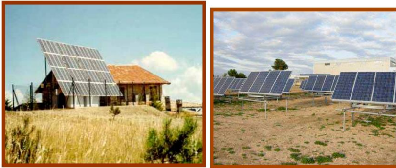
Figura 5: Impianti non integrati(da sx: agli edifici e al suolo).
