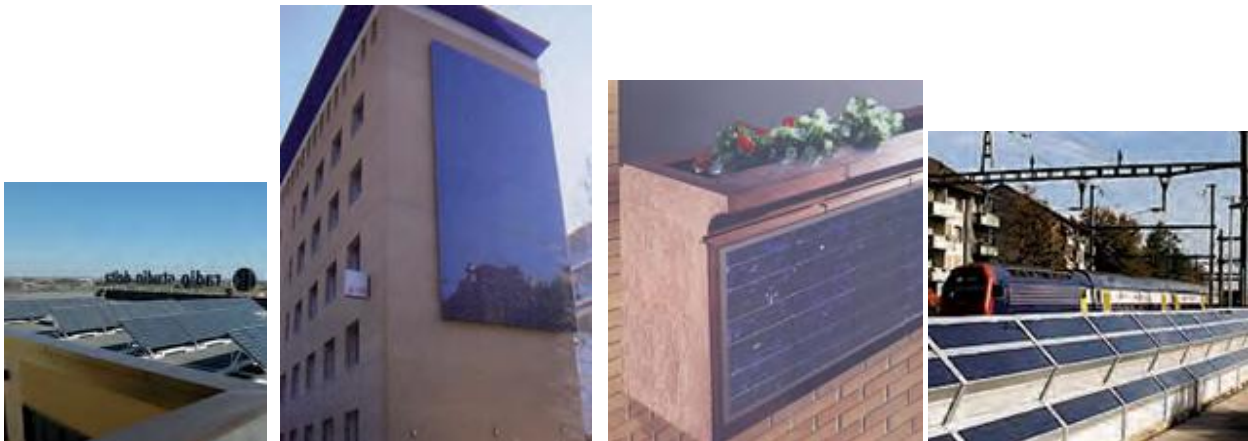
Figura 4: Esempi di impianti fotovoltaici parzialmente integrati (da in alto a sx: su tetto, su facciata, su terrazza, su barriera acustica). (Fonte GSE)
