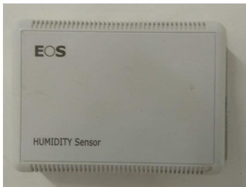
Fig.3.25 - Umidostato in soggiorno per il controllo monozona dell'UR
