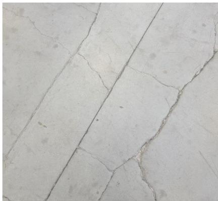
*Figura 4.15: Crepe presenti sulla pavimentazione dello stabilimento*
