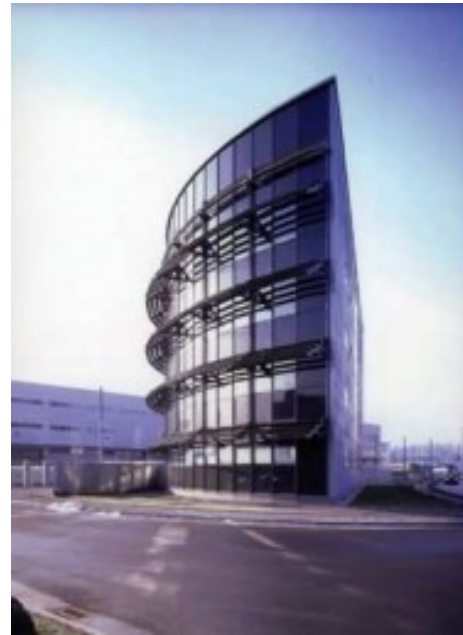
Figura 56:Foto uffici con applicazione frangisole fotovoltaico, Linz, Austria, 1999
