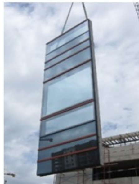
Figura 19: rappresentazione schematica sistema a cellule prefabbricate, Guida alla posa in opera delle Facciate Continue, UNCSAAL
