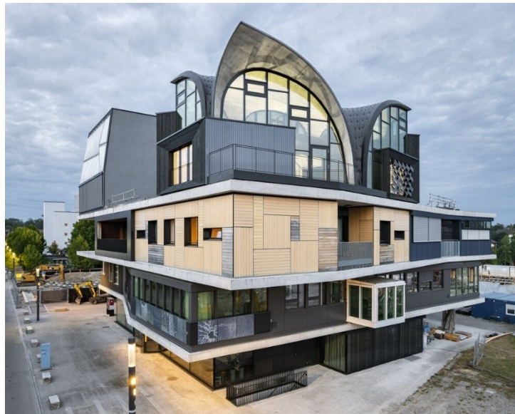
Figura 50: Unità HiLo NEST, 2021, Zurigo, tratto da https://systems.arch.ethz.ch/demonstrators/nest-hilo
