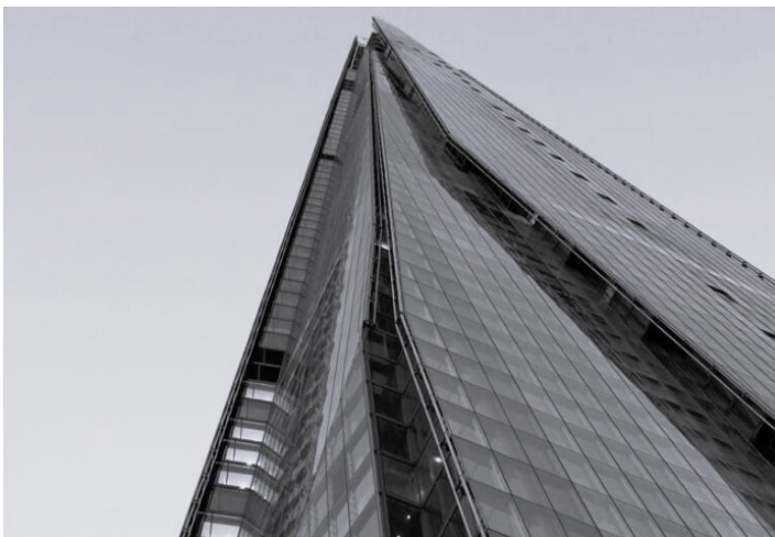
Figura 34.2: The Shard , vista facciata
