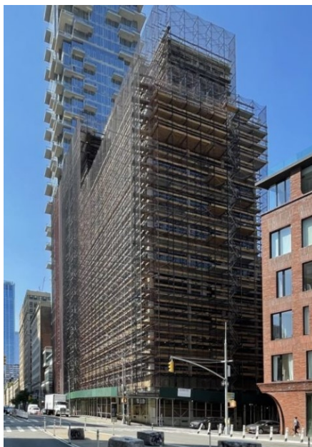
Figura 18.2: Dettaglio ponteggi in fase di montaggio
