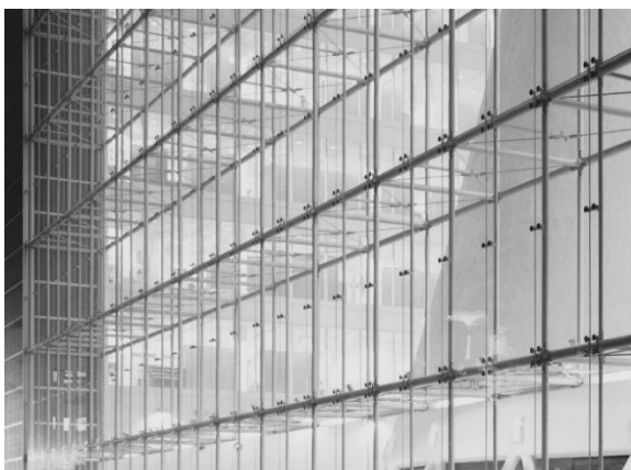
Figura 29.2: Dettaglio facciata a fissaggio puntuale
