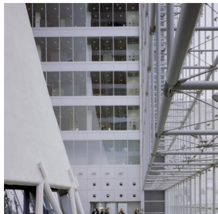
Figura 29.3: Dettaglio interno facciata a fissaggio puntuale
