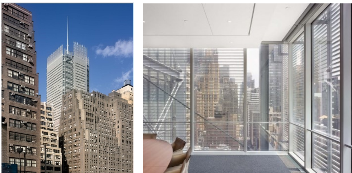
Figura 39: a- Times Building, New York, tratte da www.fondazionerenzopiano.org ; b-Times building, New York, vista dall'interno, tratta da www.fondazionerenzopiano.org
