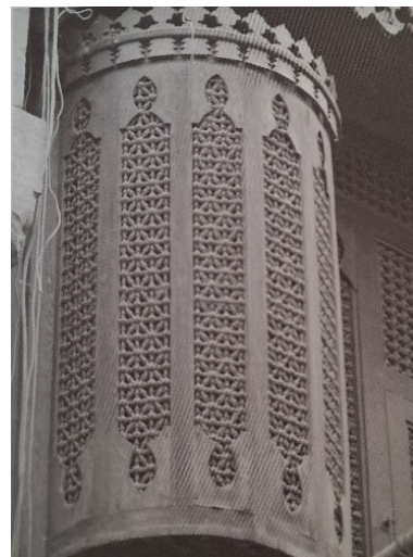
Figura 36: Esempio mashrabiyya, tratto da Schermature solari: evoluzione, progettazione e soluzioni tecniche
