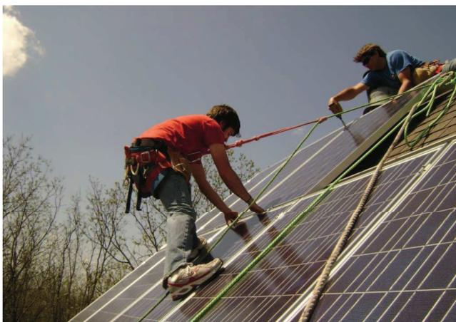
Figura 1.3: Installazione di un impianto fotovoltaico
