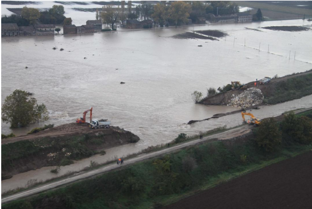
Fig.16. La rotta del Frassinone in comune di Saletto nell'evento alluvionale del 31/10/2010 - 03/11/2010 in Veneto (fonte: Piano di gestione del rischio di alluvione 2015-2021 - Distretto idrografico delle alpi orientali, 2010)
