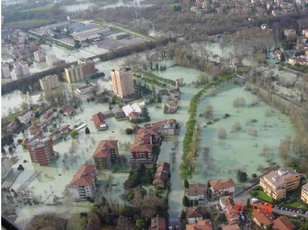
Fig.5. Pordenone, evento alluvionale del 26 - 27 Novembre 2002: esondazione del Fiume Noncello dopo la rotta arginale (Fonte: Bernardi et al.,2003)
