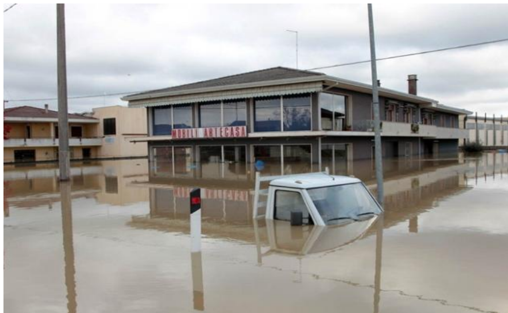
Fig.18. Evento alluvionale del 31/10/2010 - 03/11/2010 in Veneto: Bovolenta (fonte: Mattino di Padova, 2010)
