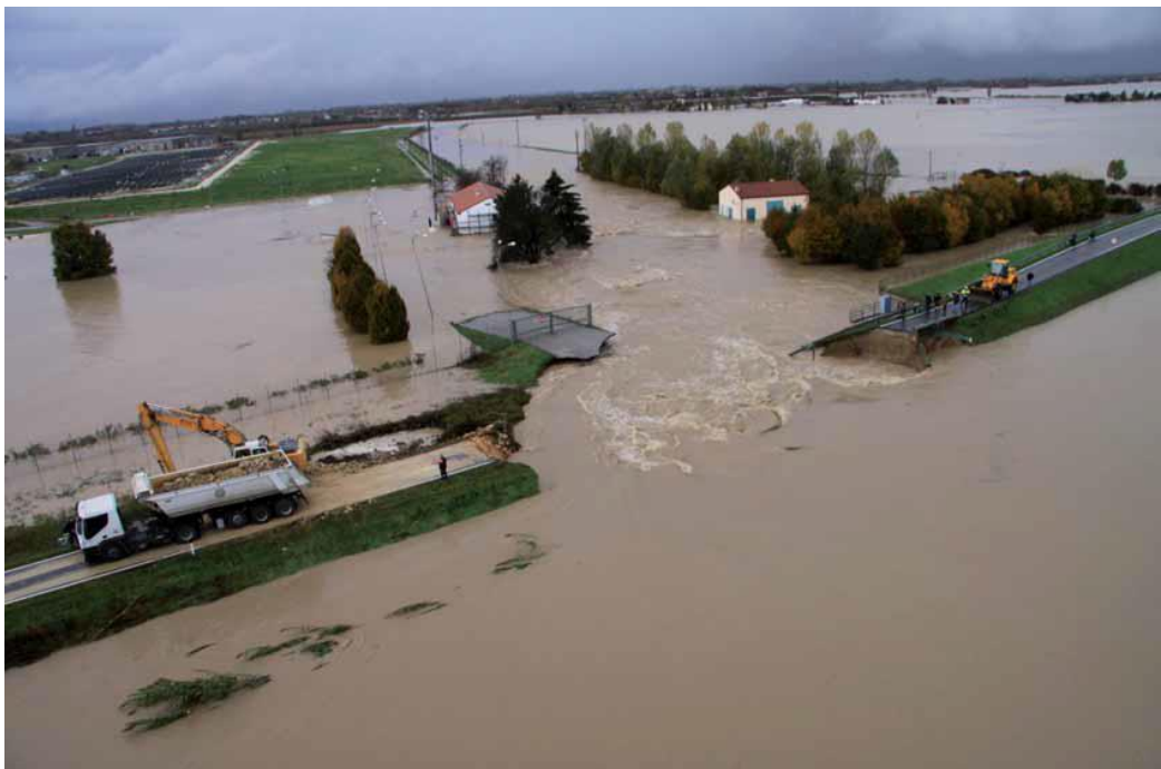
Fig.17. Evento alluvionale del 31/10/2010 - 03/11/2010 in Veneto: rotta arginale a Roncagette (fonte: Regione Veneto, 2010)
