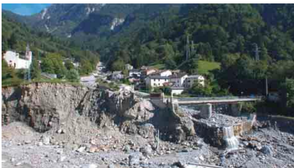
Fig.7. Evento alluvionale del 29 Agosto 2003: veduta della frazione di Pietratagliata in Comune di Pontebba. Disastrose conseguenze dovute alla violenta erosione del fondo e della sponda in sinistra idrografica del fiume Fella (Fonte: APAT, 2004)
