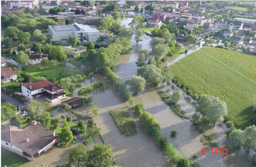
Fig. 10. Evento alluvionale del 9 settembre 2005 a Fiume Veneto: esondazione del Fiume Fiume (fonte: Protezione Civile FVG, 2005)
