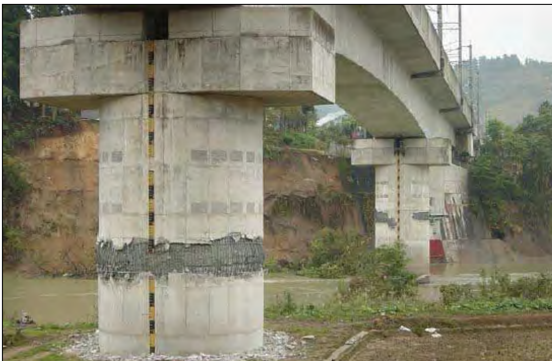
Figura 2.9 - Corretta progettazione e formazione di cerniera plastica a seguito di evento sismico (terremoto di Chuetsu, Niigata Prefecture, Giappone, 2004).
