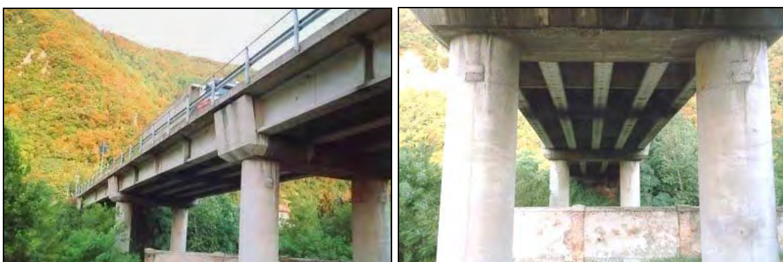
Figura 4.3 - Vista delle pile a telaio e dell'impalcato del ponte di Fener.
