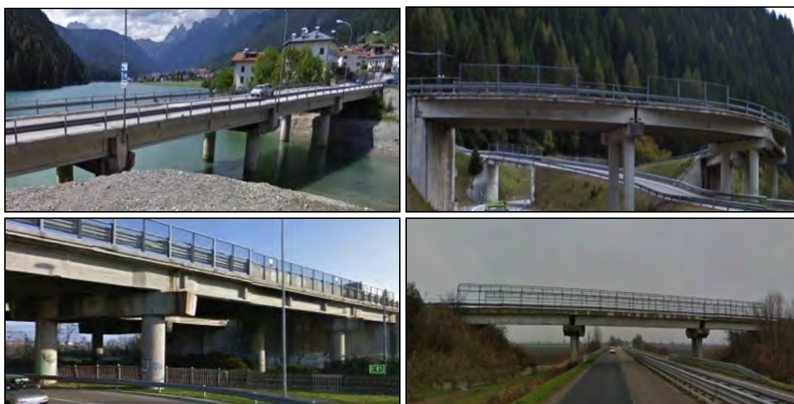
Figura 1.2 - Alcuni dei ponti presenti nel Veneto caratterizzati dalla tipologia strutturale analizzata: il ponte di San Nicolò Complico, il ponte di attraversamento della SS52, il ponte di attraversamento ferroviario di Villafranca, il ponte di attraversamento della SS434.
