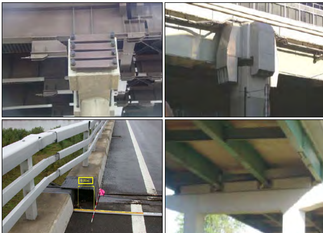
Figura 2.25 - Intervento di aggiunta di ritegni longitudinali e trasversali.
