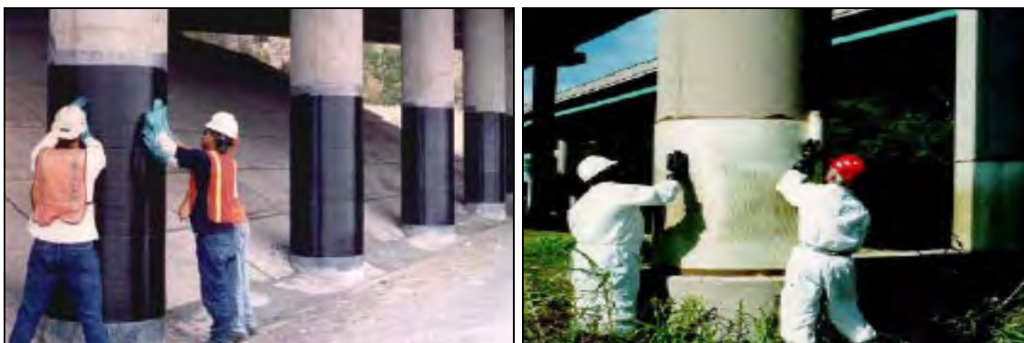
Figura 2.28 - Intervento di rinforzo delle pile mediante l'utilizzo di materiali compositi.
