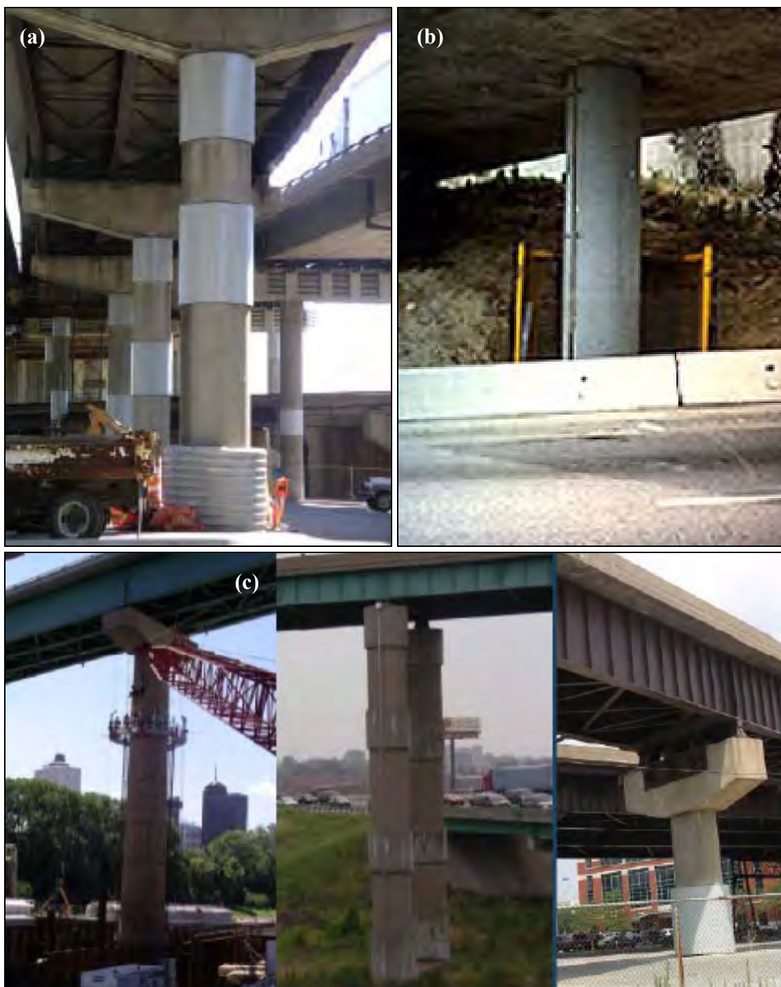
Figura 2.27 - Intervento di rinforzo delle pile: (a) e (b) confinamento con piatti metallici; (c) aumento della sezione con getti in c.a..
