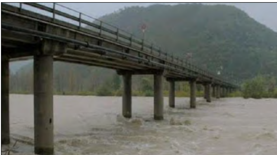
Figura 4.2 - Vista delle pile in alveo durante una piena del fiume Piave.
