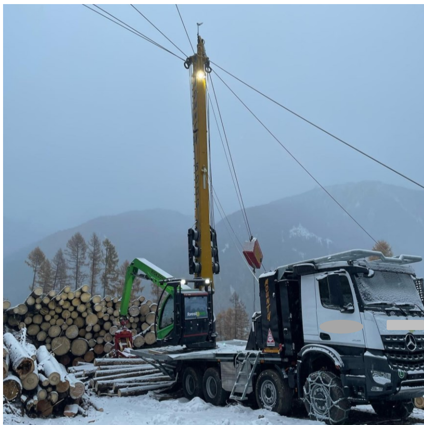
Figura 4.6: Cantiere con macchina combinata dotata di gru a cavo trifune e braccio con testata processor
