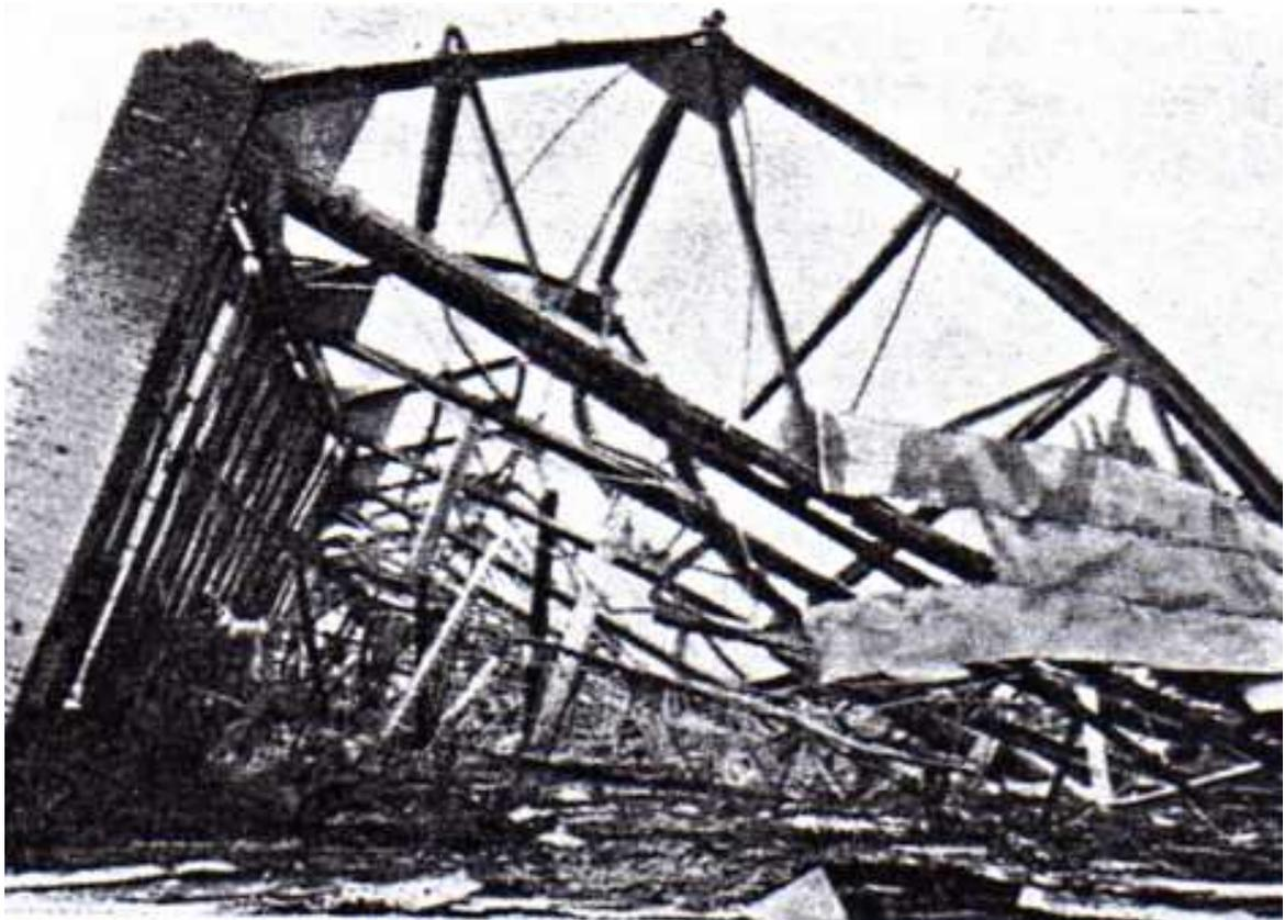
Fig. 9.2.1 Effetti disastrosi di un incendio in stabilimento a muri di mattoni e con struttura portante metallica (American Institute of Timber Construction).
