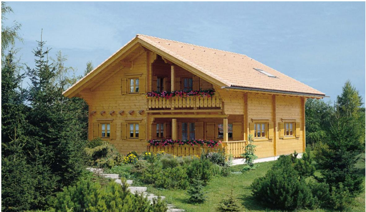
Fig. 8.4.1 Edificio con struttura a blocchi massicci utilizzati anche come finitura esterna. (Federlegno-arredo, 2005, Legno massiccio in edilizia)
