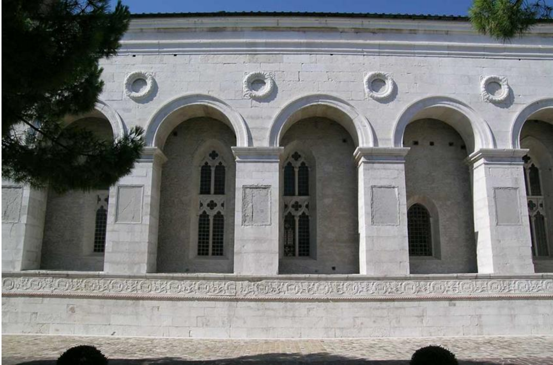
Figura 1.4: Rimini, fianco del tempio malatestiano caratterizzato da archi che poggiano su pilastri massicci di tipo romano
