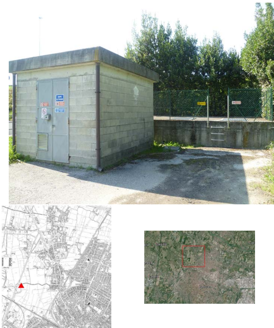
Figura 8: Stazione di sollevamento in prossimità del sottopasso Stadio Euganeo
