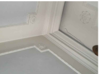
10F Essurazione del controsfondo
