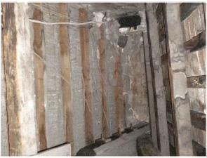
1D) Infiltrazioni d'acqua tra gli arcatecci: dissecchi e monaco sulla parete che gravano sul cornicione
