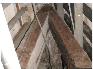
12) Interventi esistenti di consolidamento dell'appoggio della capriata
