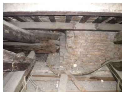
Figura 7.24: foto del paramento sul quale è stata eseguita la valutazione dell'I.Q.M.
