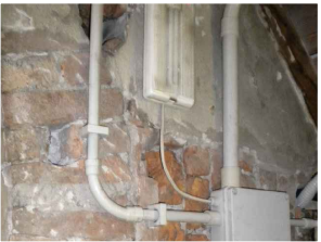
1D Presenza di fori di passaggio impiantistico nella muratura al di sopra dell'attacco non opportunamente risolti
