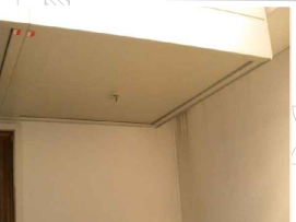
4D Alterazione cromatica dell'affresco promossa da ponte termico
