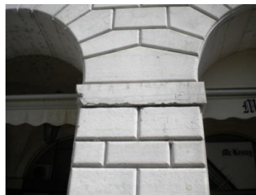
Figura 7.26: La muratura in blocchi lapidei dei pilastri al pian terreno dell' Ala Moschini .
