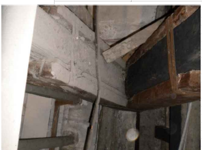
11) Interventi esistenti di consolidamento dell'appoggio della capriata
