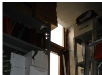
Figura 7.30: il solaio che si suppone essere il laterocemento.
