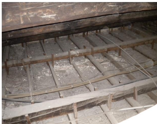
Figura 7.21: estradosso del controsoffitto in arelle al terzo piano.
