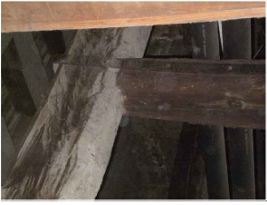
8D) Monaco della capriata che poggia sulla catena
