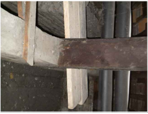
7D) Monaco della capriata che poggia sulla catena
