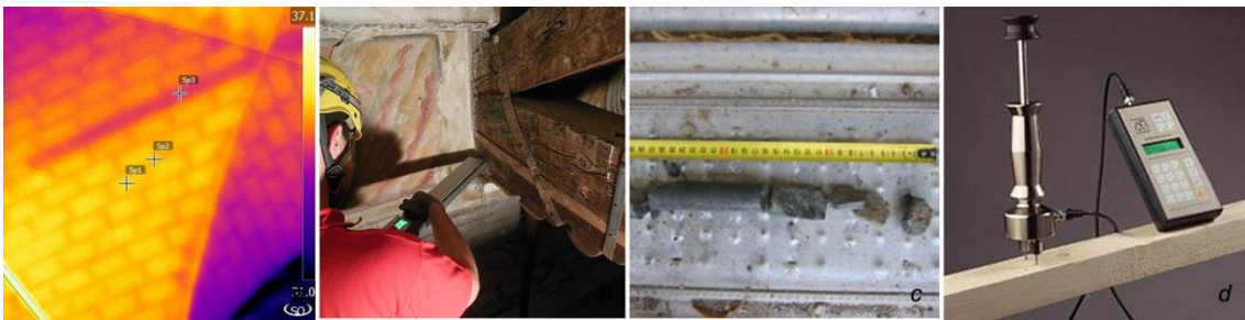
Figura 6.3: a) [W7] termografia; b) Resistograph; c) carotaggio; d) [W13] igrometro da legno.
