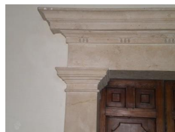
Figura 7.20: presenza di architravi in pietra al piano nobile del palazzo cinquecentesco.
