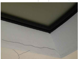
3F Lesione verticale sull'imbottite della porta
