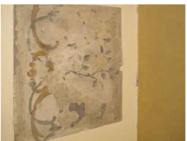
9D Fessurazione del controsoffitto in corrispondenza della parete
