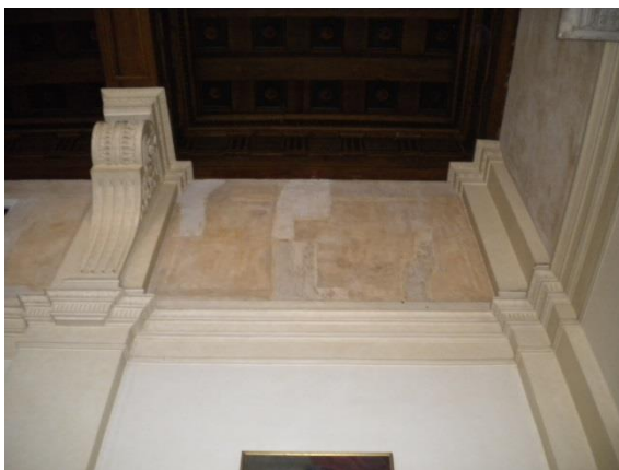
Figura 7.22: controsoffitto ligneo della Sala del Consiglio.
