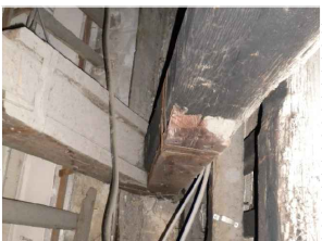
10) Interventi esistenti di consolidamento dell'appoggio delle capriate
