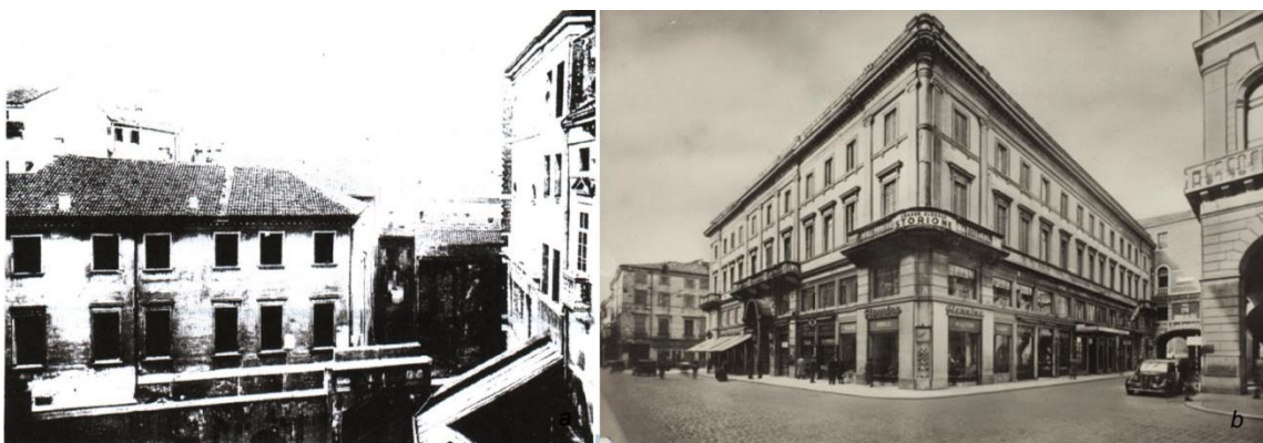
Figura 3.17: a) l'isolato del gallo con Vicolo Storione, demolito per lasciar posto al nuovo progetto (Lamon); b) l'Albergo Storione previsto dal Piano Lupati-Manfredini, demolito a sua volta nel 1962 (il Mattino).
