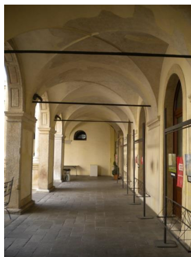
Figura 7.27: catene nelle volte a crociera del chiostro dorico.
