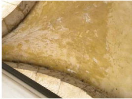
7D) Maschia sull'intonaco
