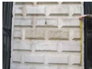
Figura 7.23: foto del paramento sul quale è stata effettuata la valutazione dell'I.Q.M.
