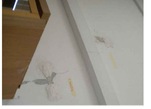
2F | Lesione diagonale monitorata con vetri data 30/05/2012
