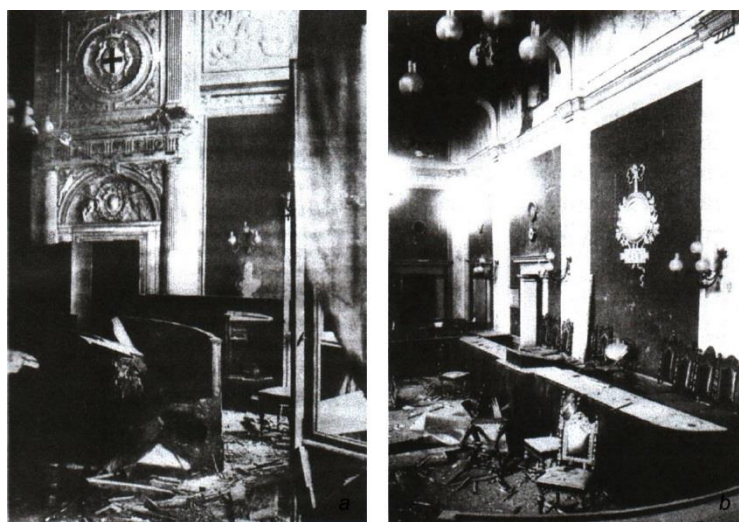
Figura 3.10: a-b) [B16] danni nella Sala del Consiglio a seguito di una bomba.
