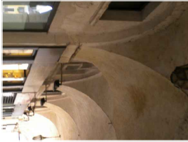
5D) Alterazione cromatica dell'intonaco sulla volta
