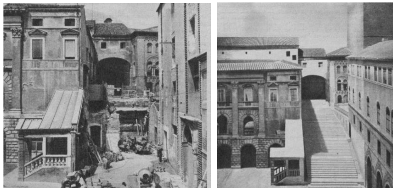
Figura 3.11: [A3] Sistemazione degli uffici comunali: a) lavori per la costruzione dello scalone d'onore (1963); b) plastico d'epoca del Palazzo Centrale, a sistemazione avvenuta, Archivio Generale del Comune di Padova.
