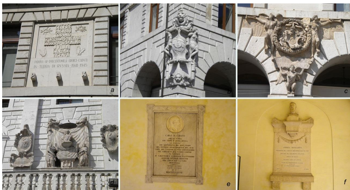
Figura 4.5: alcuni tra i monumenti presenti nelle facciate e nel chiostro dorico: a) targa commemorativa dei caduti in Russia nella Seconda Guerra Mondiale, facciata su via S. Canziano; b) Stemma di Marcantonio Contarini (1539-1541), promotore della fabbrica, situato nell'angolo tra il prospetto sud ed ovest; c) Monumento dedicato ad Ermolao Barbaro, situato tra la terza e la quarta arcata della facciata Sud; d) Monumento a Domenico Gritti, posto in facciata a tamponatura di una finestra della Sala della Giunta nel 1842; e) Monumento a Carlo Cerato, chiostro dorico; f) monumento ad Andrea Meneghini, chiostro dorico.
