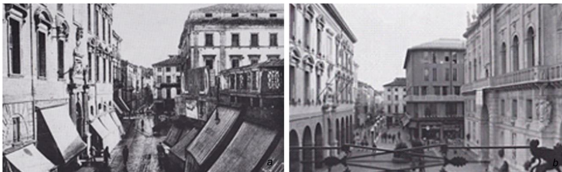
Figura 3.2: Via VIII febbraio e Canton del Gallo, visti dal caffè Pedrocchi: a) agli inizi del Novecento; b) oggi, con la sede della Banca Antoniana dove sorgeva l'albergo allo Storione e con la facciata orientale del Palazzo Moretti-Scarpari, costruita nel 1922-1930. (Giuriati, 1992).
