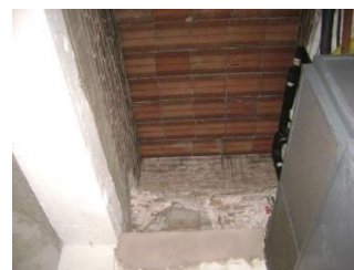
Figura 7.29: solaio in laterocemento al piano terra.
