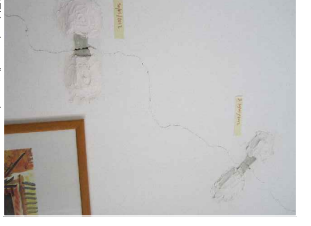
3F | Lesione diagonale passante monitorata con vetri data 30/05/2012
