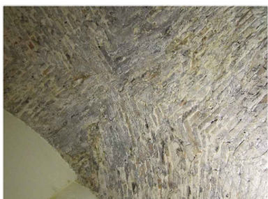
130| Distribuzione irregolare della malta, alterazione cromatica dei mattoni
