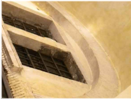
8D) Costa nera sulla cornice della finestra, alterazione cromatica sull'arco
