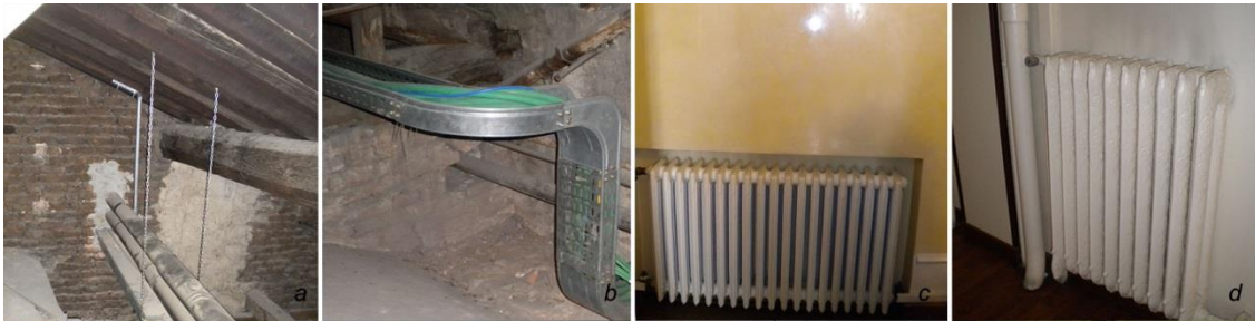
Figura 8.3: a) tubazioni in copertura; b) frenelli della volta nella Sala dei Nodari ; c-d) confronto tra il riscaldamento nel palazzo cinquecentesco e nell' Ala Moschini .
