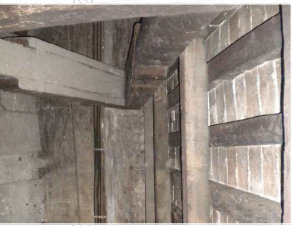
10D) Interventi di consolidamento dell'appoggio della capriata
