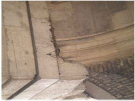
1D) Deposito superficiale sull'opusco dell'arco e maschia su mattoni
