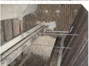
19) Aperture e ammassamenti nella muratura per il passaggio di impianti
