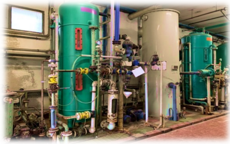
Impianto SIDA per la produzione di acqua demineralizzata. Da sinistra: torre anionica, decarbonante, cationica
