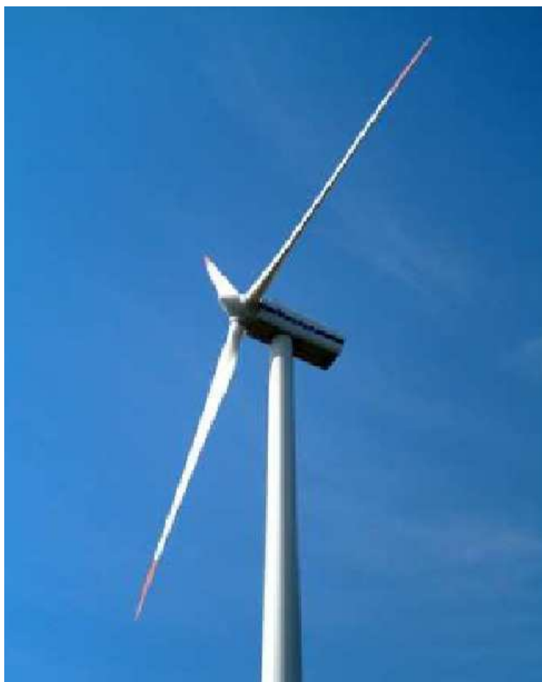
Figura 1.4: Esempio di turbina eolica ad asse orizzontale
