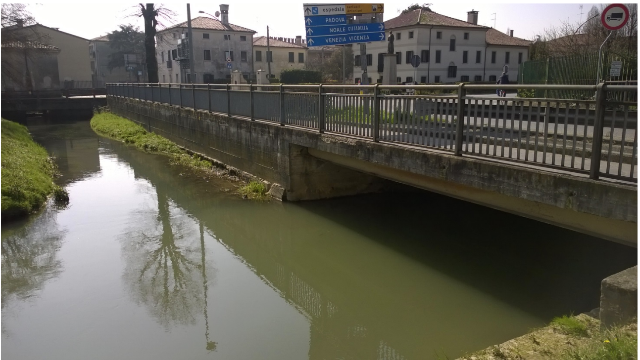
Fig.4.21 Confluenza tra il Muson Vecchio e le acque che provengono dal sostegno Businello
