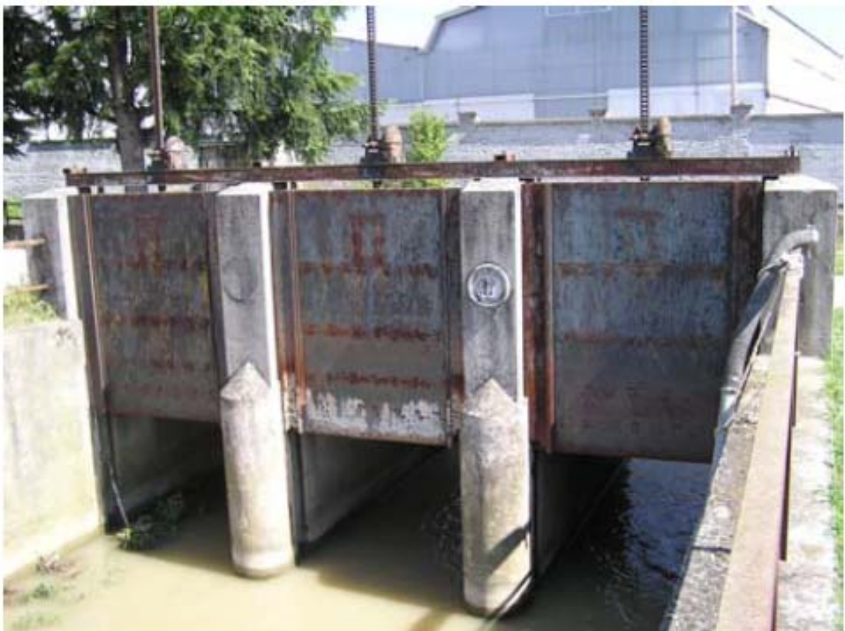
Fig. 4.16 Porte da Barban che regolano l'immissione nel Muson dei Sassi
