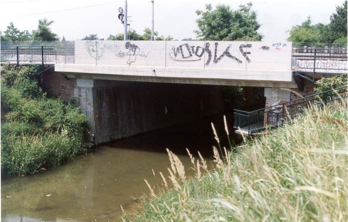
Fig. 4.3 Ponte della Ferrovia, Castelfranco Veneto (TV)
