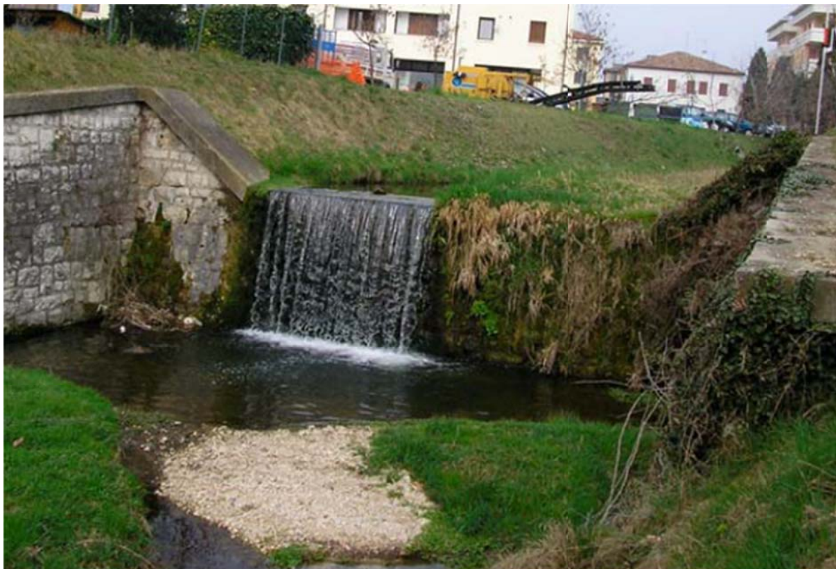
Fig. 4.1 Salto di fondo sul torrente Lastego presso Onè di Fonte
