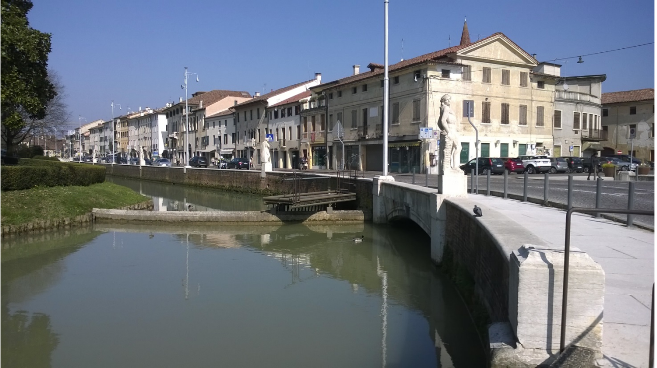
Fig. 4.14 Immissione dell'Avenale nelle Fosse Civiche, con soglia separatrice dei deflussi
