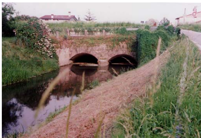
Fig. 1.8 Pontecanale del fiume Muson Vecchio sotto il torrente Muson dei Sassi
