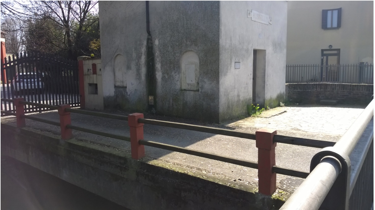
Fig.4.20 Camposampiero, sostegno Businello
