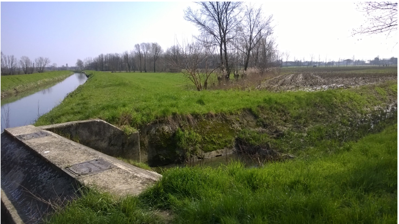
Fig. 4.10 Confluenza Vandura - Mauri e sifone autolivellante
