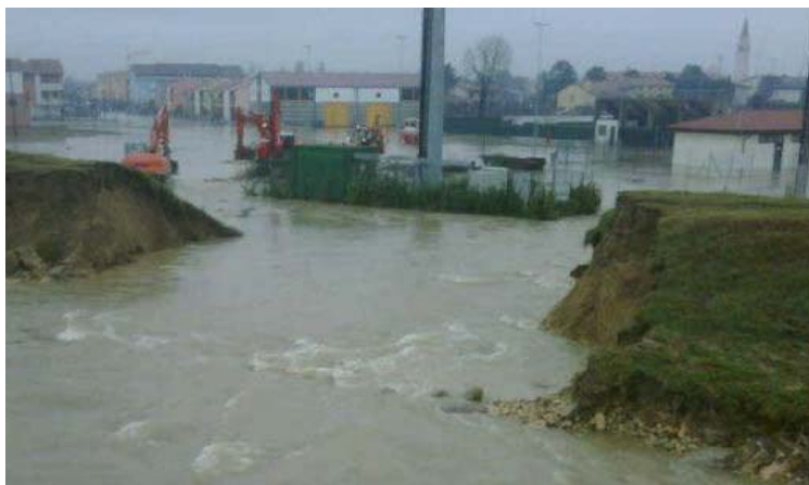
Fig. 1.13 Il crollo dell'argine a Loreggia, 21 gennaio 2009
