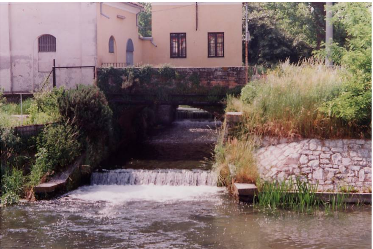
Fig.4.23 Muson Vecchio a valle del sostegno Antonello
