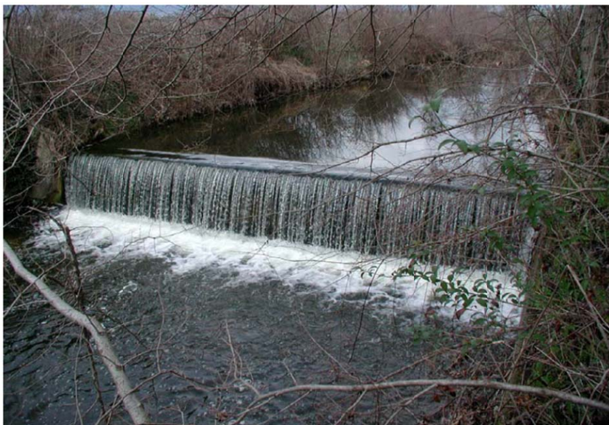
Fig. 4.2 Salto di Fondo sul torrente Muson presso Aolo
