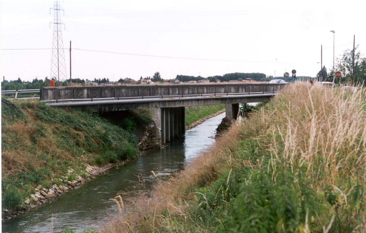
Fig. 4.4 Ponte delle Galle, Camposampiero (PD)
