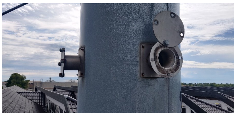
Figura 2.1: tronchetto di prelievo munito di controflangia
