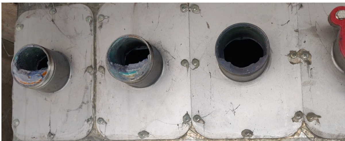
Figura 2.25: foto d'un punto di prelievo per il campionamento di flussi gassosi convogliati derivanti da attività di verniciatura a polvere
