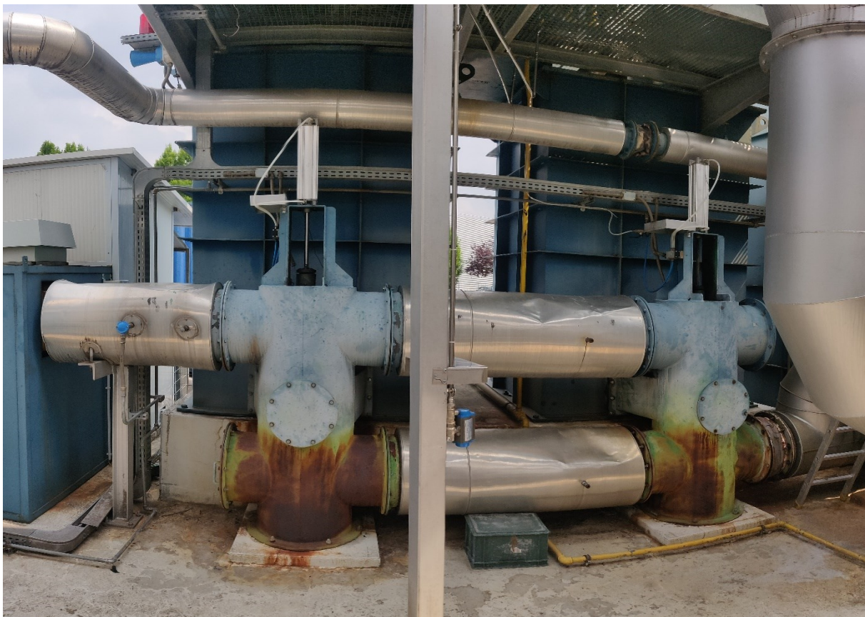
Figura 2.9: foto raffigurante le due camere del post-combustore ed il sistema pneumatico che ne permette il funzionamento alternato
