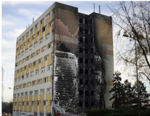
Figura 3.1 Analisi storica dei casi di incendio: 2010, Dijon, Francia
