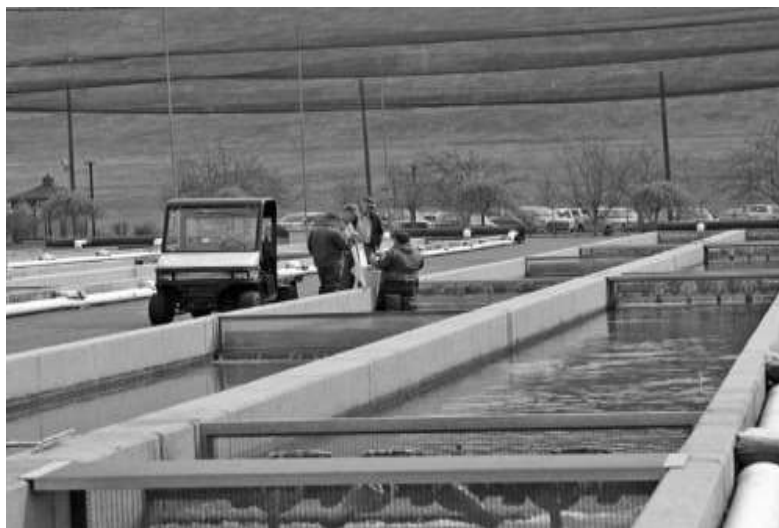
Fig. 7. Canali a deflusso.
