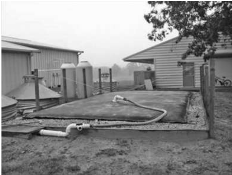
Fig.11. Contenitore geotessile su letto di ghiaia progettato per catturare l'acqua lisciviata per il riutilizzo.
