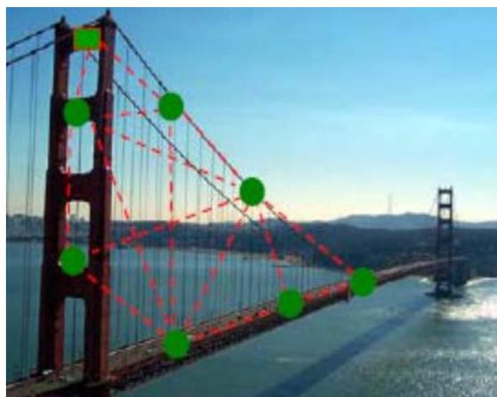
Figura 1.5: posizione dei sensori di monitoraggio strutturale nel ponte [4]
