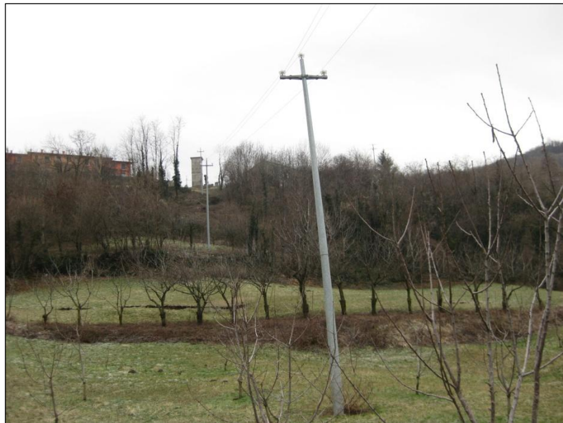
Figura 6.28 Ortofoto, CTR, fotografia della frana av2013011621 (Progetto di tesi).
