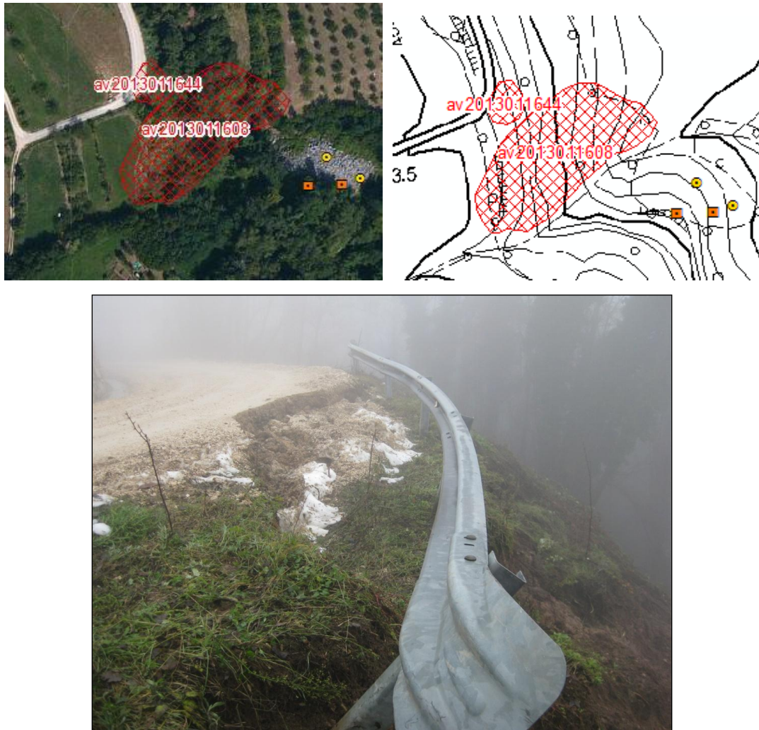
Figura 6.50 Ortofoto, CTR, fotografia della frana av2013011644 (Progetto di tesi).
