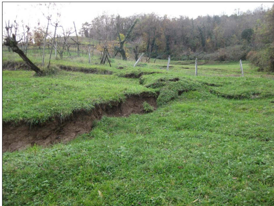
Figura 6.21 Ortofoto, CTR, fotografia della frana av2013011614 (Progetto di tesi).
