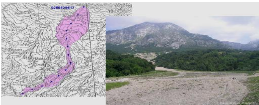
Figura 3.8 Perimetrazione e foto della frana del Tessina – comune di Chies d'Alpago (BL). ( www.regione.veneto.it/difesadelsuolo ).
