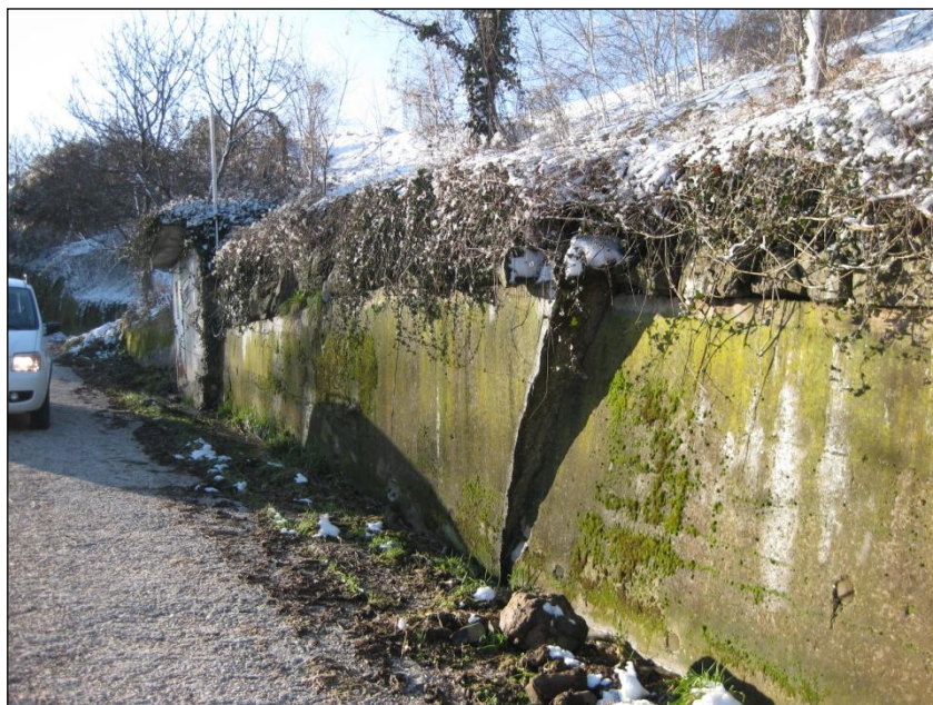
Figura 6.23 Ortofoto, CTR, fotografia della frana av2013011616 (Progetto di tesi).
