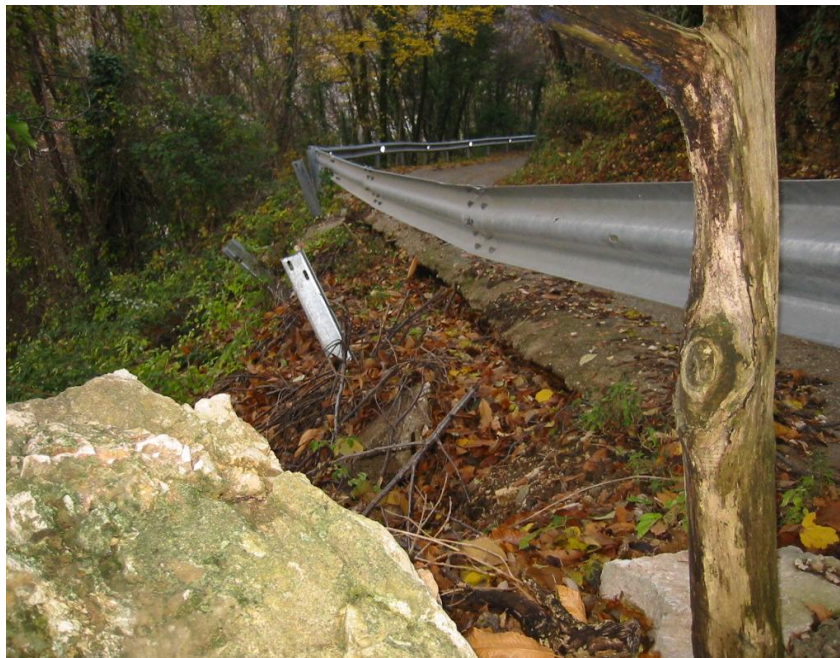
Figura 6.10 Ortofoto, CTR, fotografia della frana av2013011602 (Progetto di tesi).
