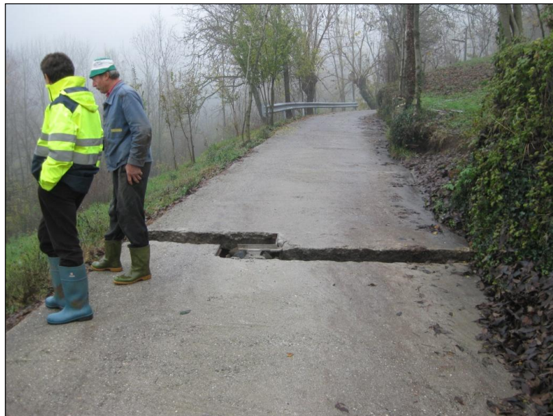
Figura 6.38 Ortofoto, CTR, fotografia della frana av20130131 (Progetto di tesi).
