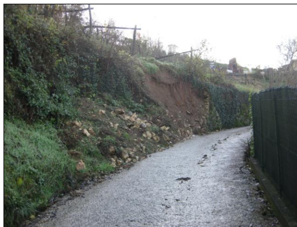
Figura 6.49 Ortofoto, CTR, fotografia della frana av2013011643 (Progetto di tesi).
