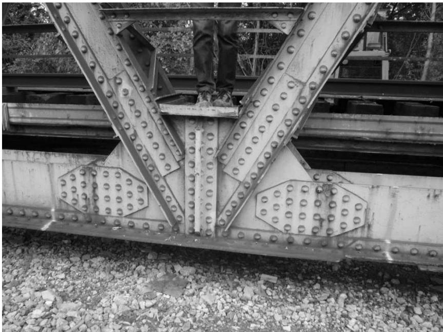
**Figura 15** – La foto in alto rappresenta la campata presa in esame per la raccolta misure. La foto in basso rappresenta il particolare del nodo successivamente testato a fatica in laboratorio
