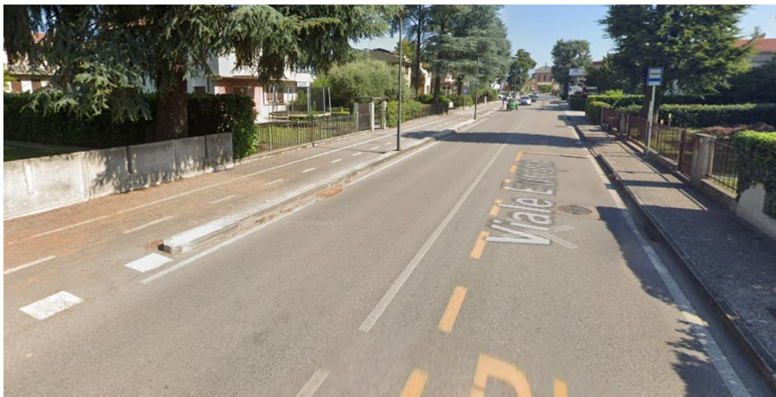
Foto 21: particolare della pista ciclopedonale in fregio a Viale Europa in direzione nord verso il centro del paese.
