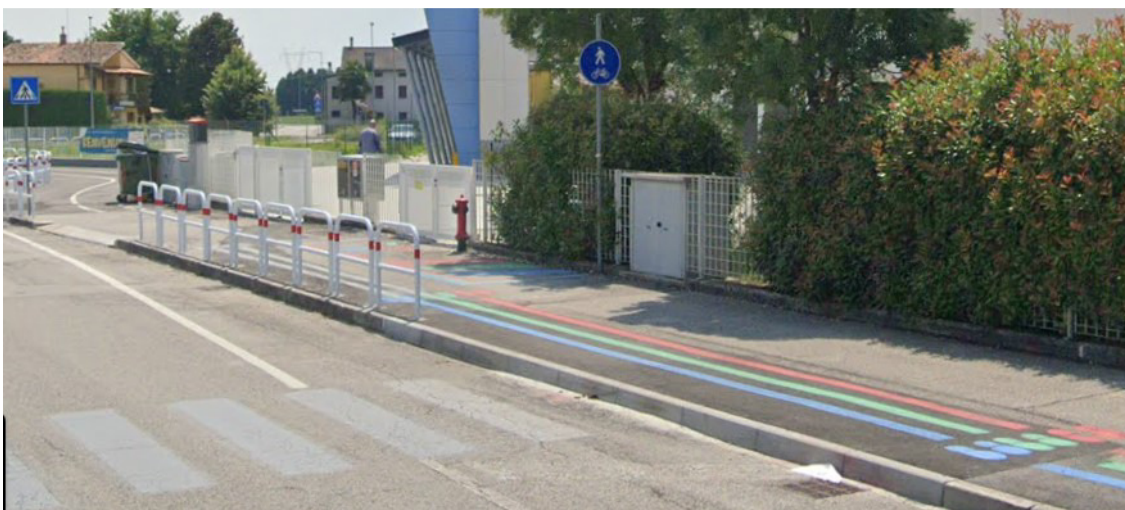
Foto 23: particolare della pista ciclopedonale in zona plesso scolastico in Via Ugo Foscolo (in sede propria e in sicurezza).
