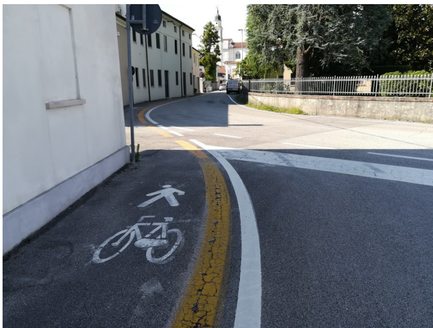
Foto 6 : particolare del percorso ciclopedonale in sede promiscua in Via Tasca (foto a cura dello studente)
