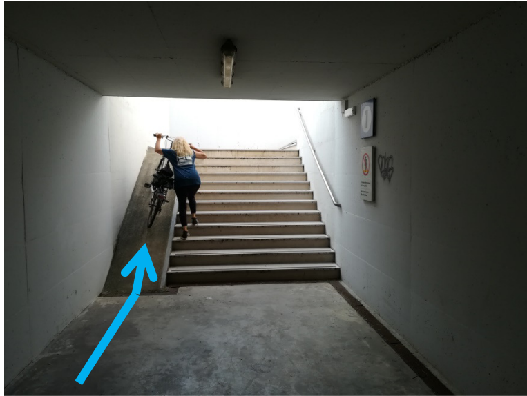
Foto 12 e 13: particolare sottopasso ferroviario con evidenza della rampa a fianco delle scale (Foto dello studente)
