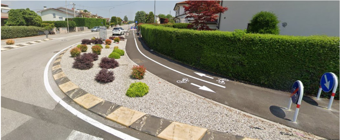
Foto 24: particolare del tratto esistente di percorso ciclopedonale su Via Mons. Belluzzo
