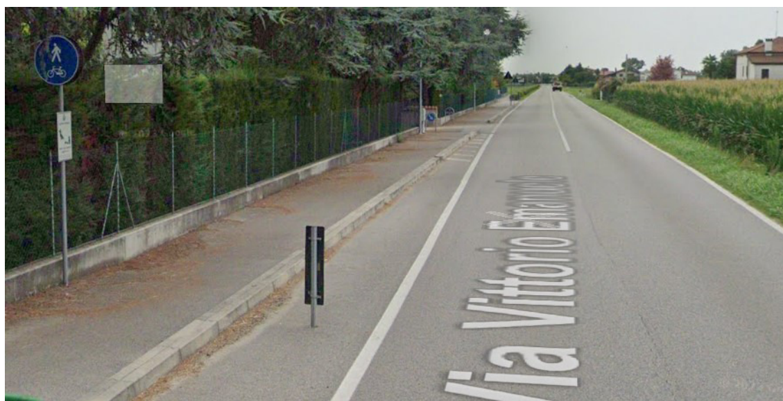
Foto 20: particolare inizio tratto ciclopedonale in sede propria che si esistente fino all'imbocco con Via G. Marconi (sviluppo 1030 m)
