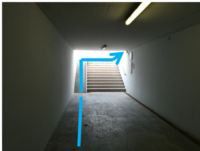
Foto 12 – particolare sottopasso ferroviario
