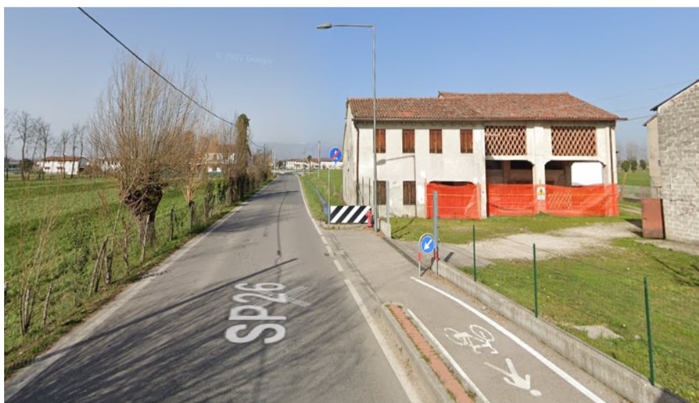
Foto 18: Via Albereria ultimazione dell'opera e limite nord del percorso ciclopedonale (2019)
