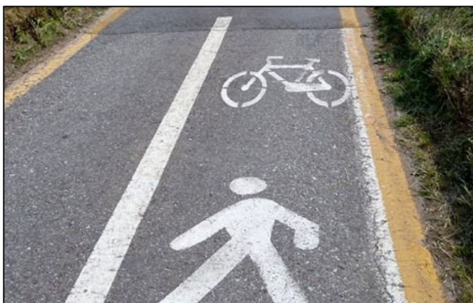
Foto 4: segnaletica orizzontale per individuazione di percorso ciclopedonale promiscuo.
