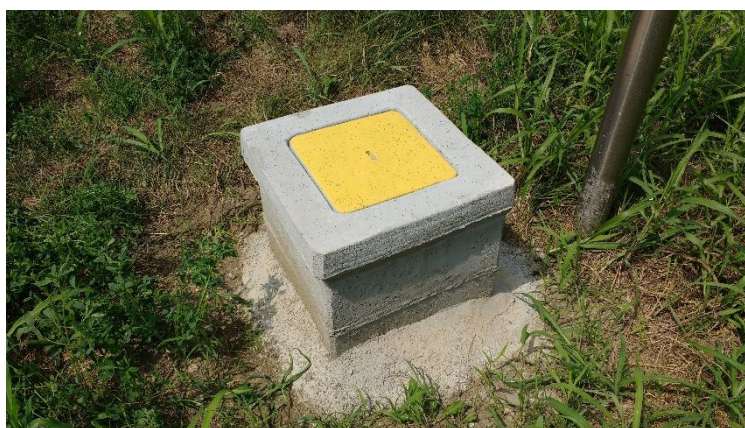
Figura 6.2. Pozzetto realizzato presso l'area del Vecchio Petrolchimico per il monitoraggio della falda
