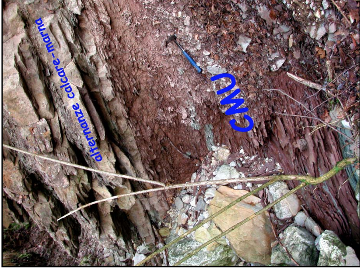
Fig. 6.11. Sezione del Torrente Cicogna (sinistra idrografica). Alla Clay Mary Unit seguono le alternanze calcare-marna.
