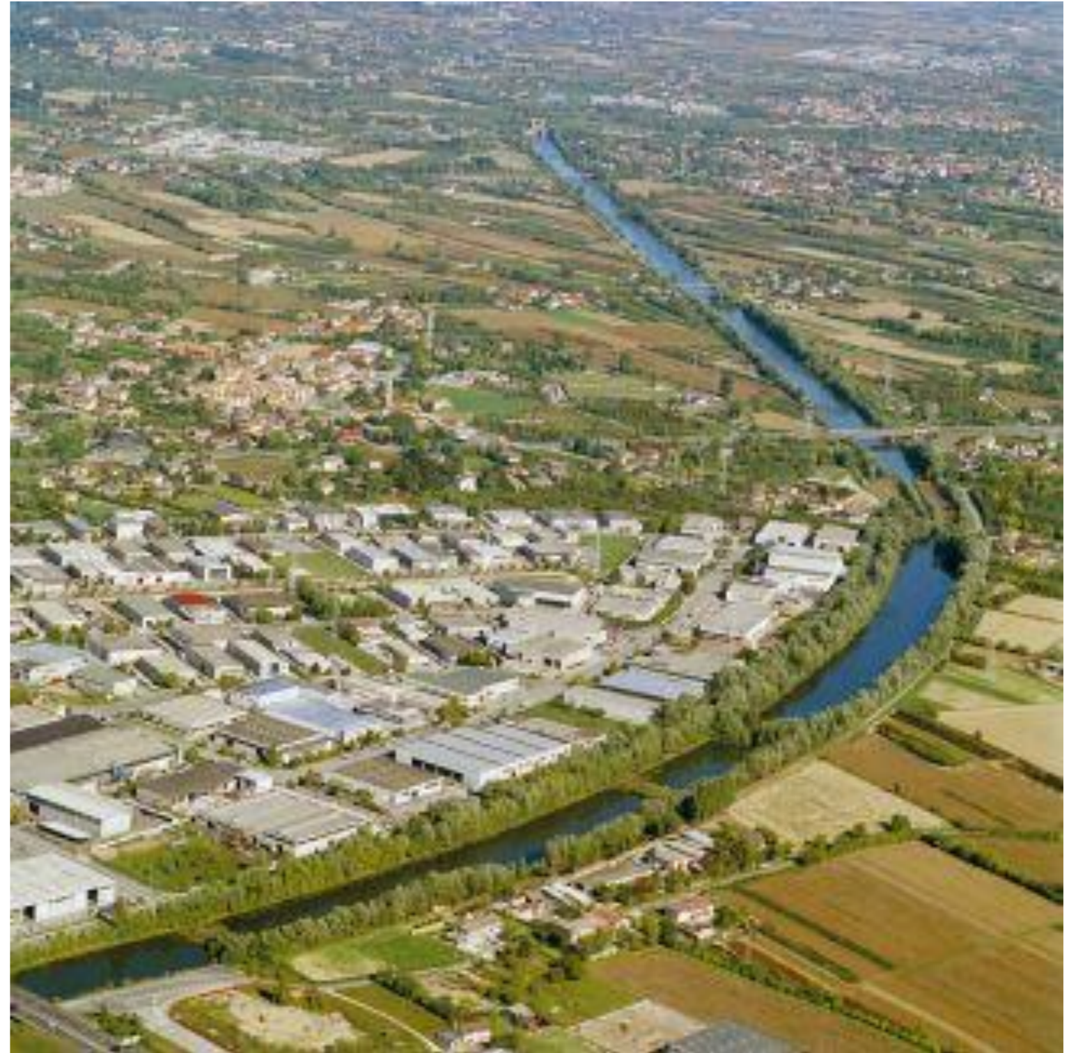
Fig. 1.11 Vista aerea dell'Idrovia Padova Venezia, Tratto realizzato nei pressi dell'Interporto di Padova, Consorzio Bacchiglione
