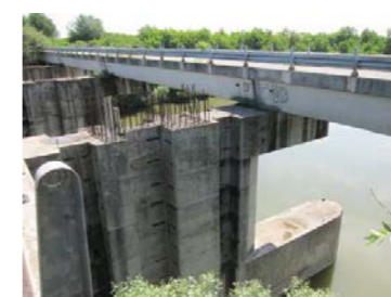
Pile e ponte stradale realizzato
