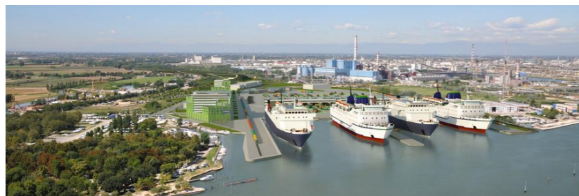
Fig 6.4 Progetto Nuovo Terminal Traghetti di Fusina, attualmente non ultimato
