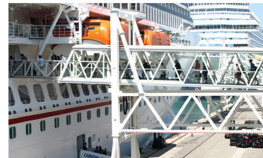
Fig 8.16 Esempio di passerella pedonale di connessione tra il Terminal Crociera e la Nave da Crociera
