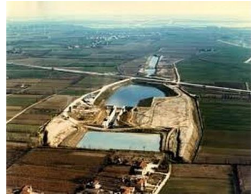
Fig. 2.2 Veduta aerea della conca Gusso, durante la fase di esecuzione dei lavori
