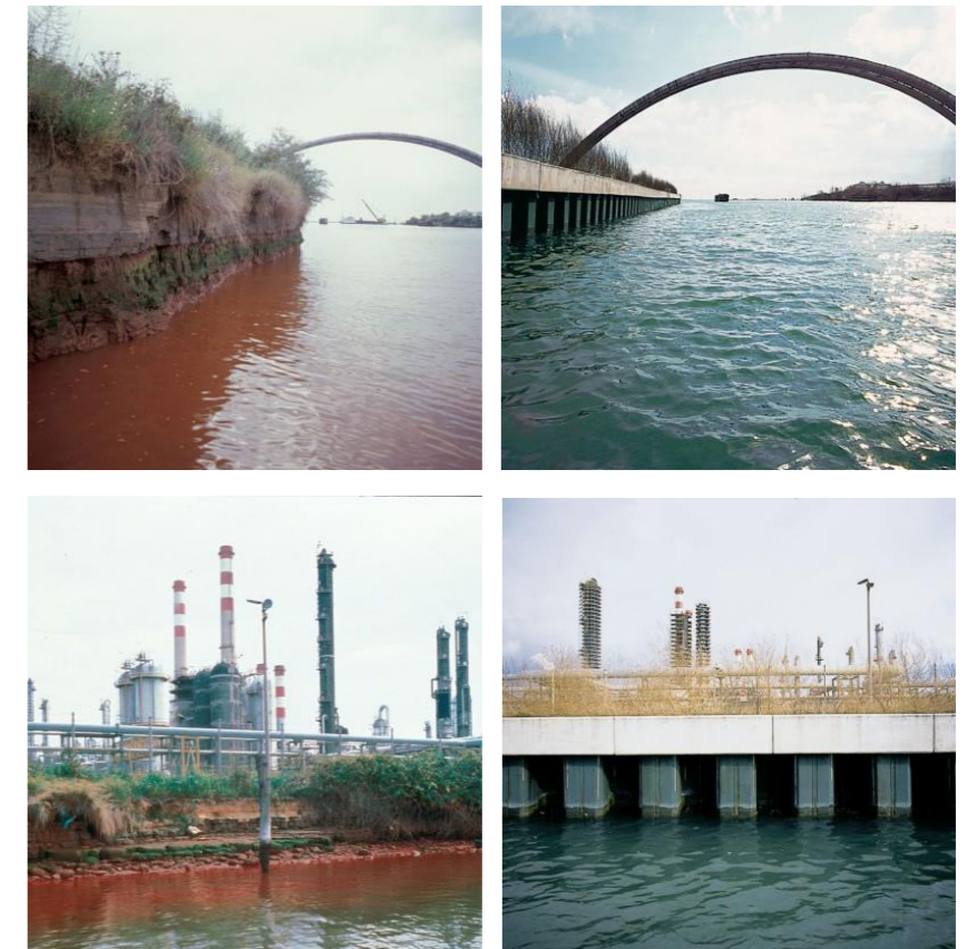
Fig 3.8 messa in sicurezza dei siti inquinati e rifacimento delle arginature lungo il Canale dell'Industria Sud, foto prima e dopo l'intervento, www.mosevenezia.eu
