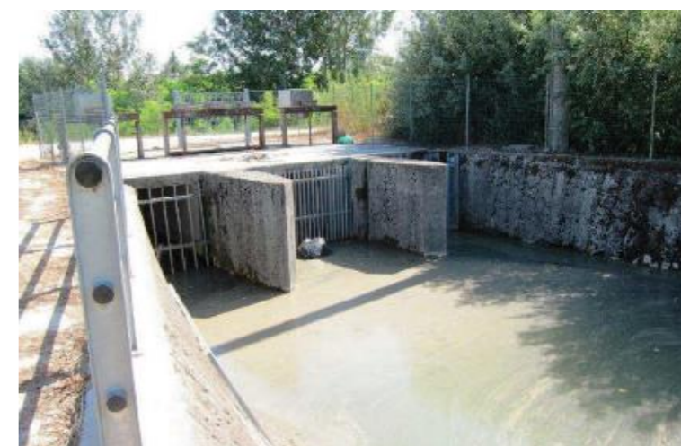
Fig. 2.5 Interferenza idraulica: Botte a sifone per scolo acque meteoriche
