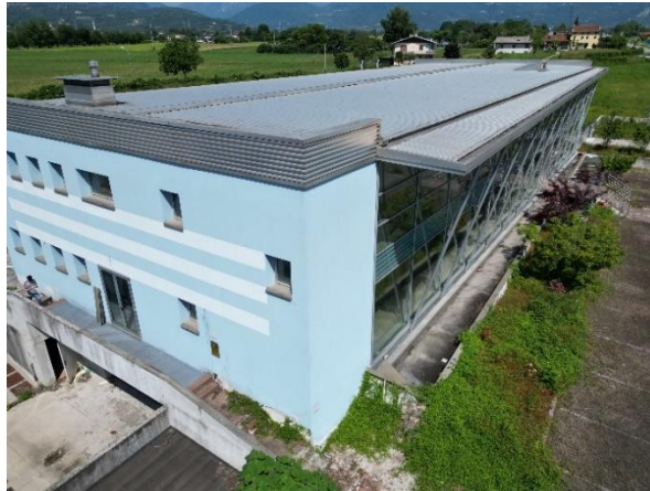
Figura 2 Foto che ritrae l'edificio all'interno del lotto
