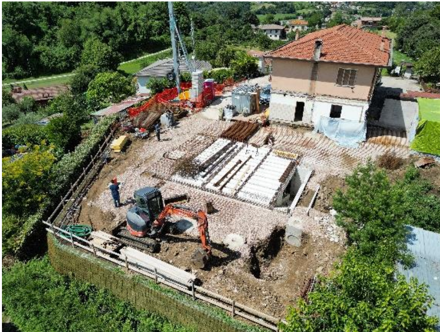
Figura 8 Foto che ritrae la zona di lavoro
