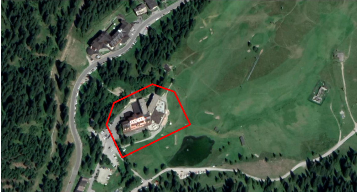
Figura 7 Ortofoto con individuazione della struttura
