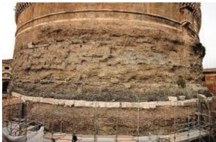
Fig. 3 – vista del nucleo cementizio sul tamburo del Mausoleo di Adriano. (M. Bertinetti, A. Fabiani, P. Marchetti, C. Palombi, M.L. Santarelli – Bollettino di archeologia online, VI, 2015/1, pp. 36)
