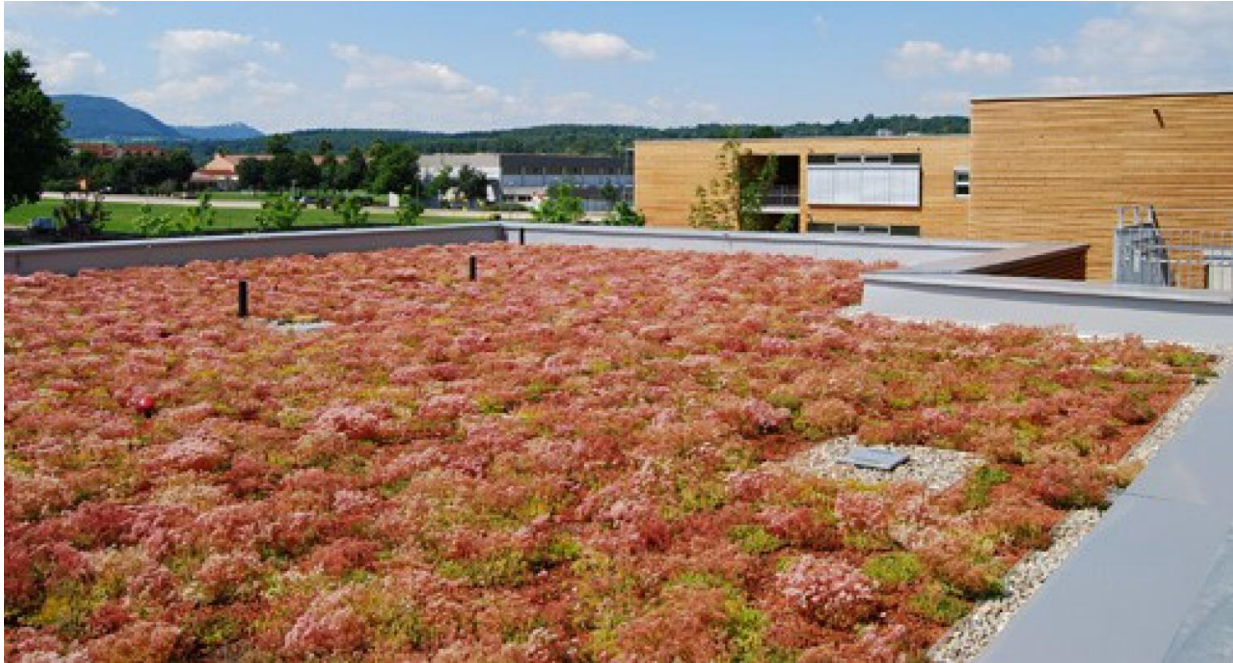
Figura 6: Esempio di tetto verde estensivo (Fonte https://zinco-italia.it/ )
