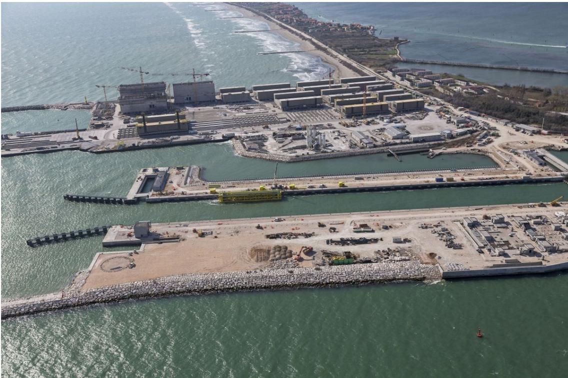
*Figura 5. Conca di navigazione realizzata a Malamocco, essa è un canale parallelo alle bocche di porto che possiede due porte (una a lato mare ed una a lato laguna).*
