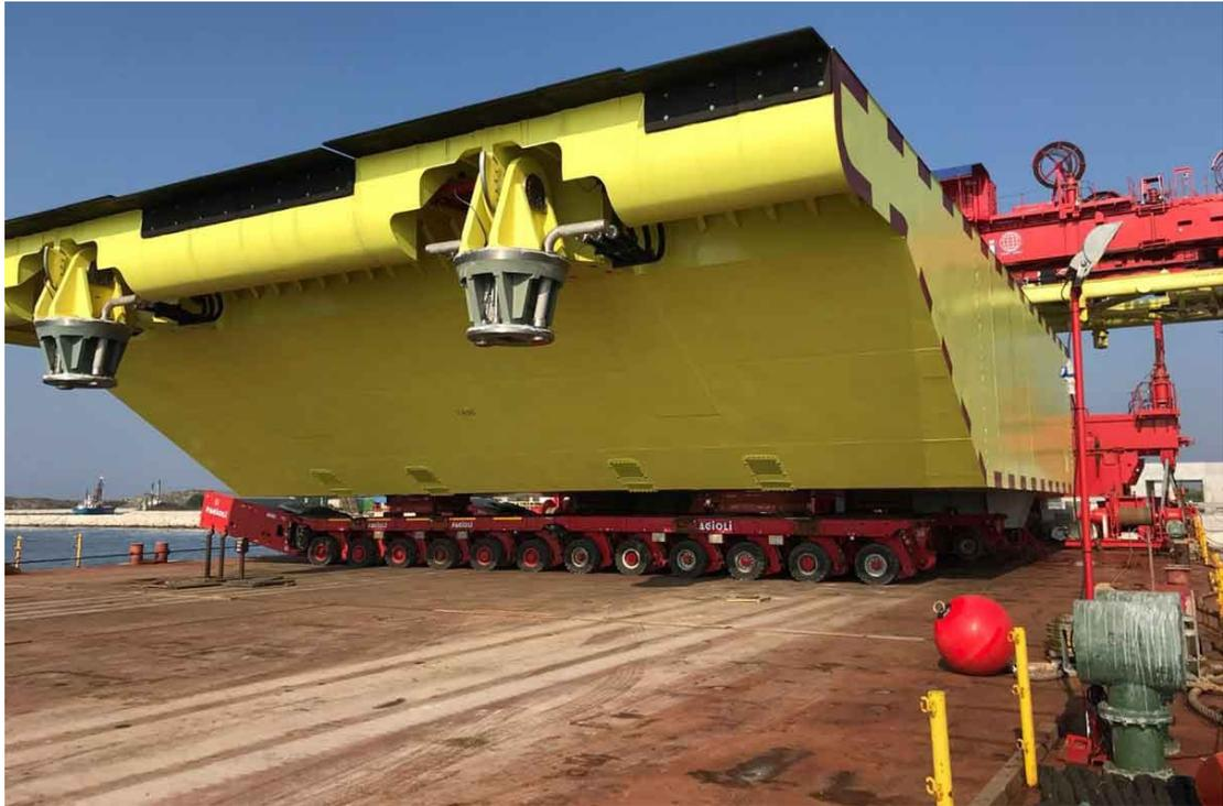
*Figura 4. Paratoia del Mo.S.E. durante le operazioni di trasporto. Da questa angolazione è possibile apprezzare il gruppo cerniera-connettori e la vernice con cui è ricoperta la superficie esterna.*
