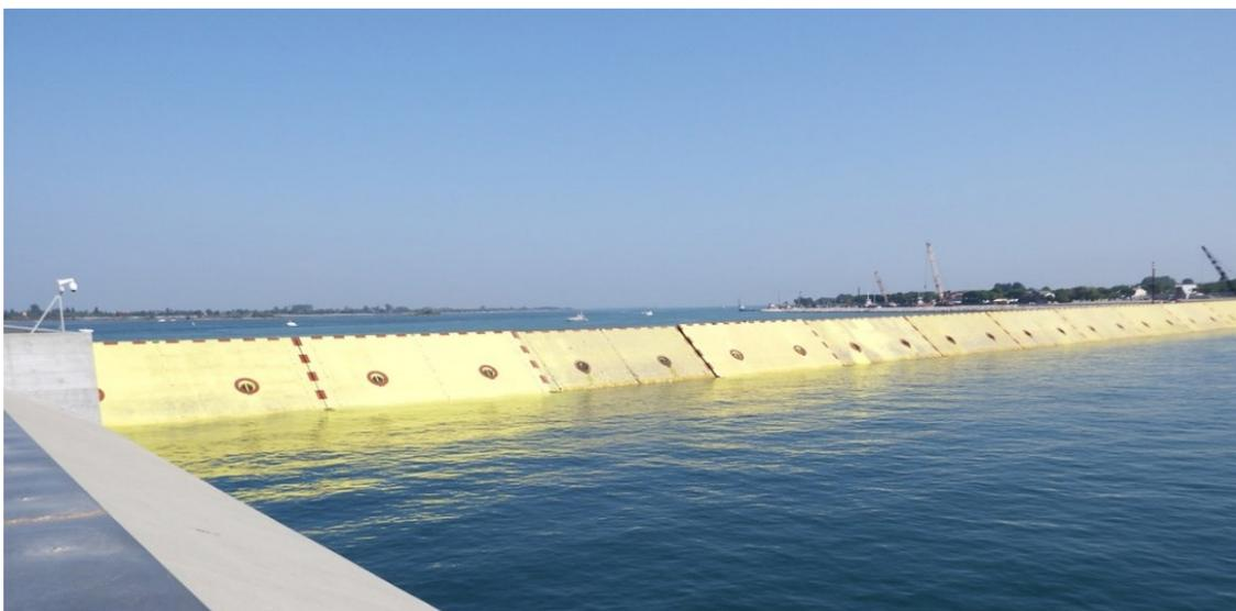
*Figura 1. La bocca di porto di Chioggia con le paratoie del Mo.S.E. in funzione. Gli elementi gialli sono le paratoie, l'insieme delle paratoie costituisce lo sbarramento. Fonte: sito web Consorzio Venezia Nuova*
