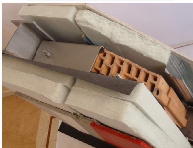
Fig. 3.1: Pacchetto parete Sistema IN.NOVA: rendering e particolare realizzato in scala reale del pannello in laterizio.
