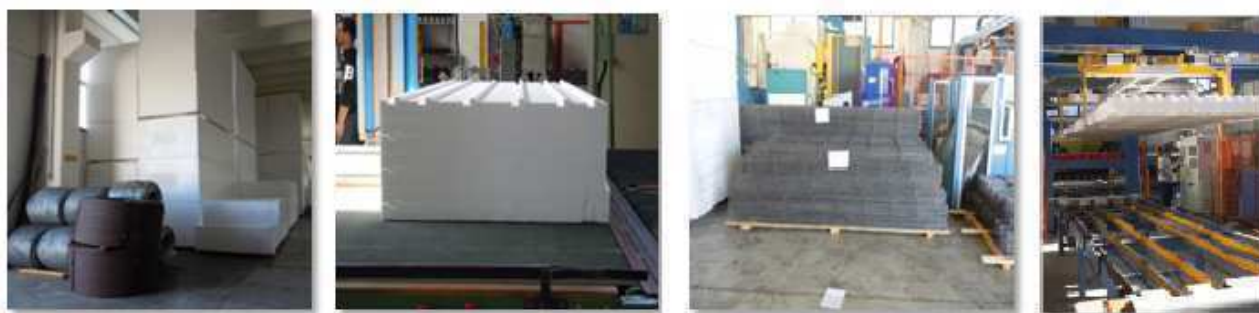
Fig. 2.4: Fasi di realizzazione dei pannelli: arrivo del materiale in stabilimento, intaglio del polistirene, assemblaggio delle reti, assemblaggio dei pannelli con le reti.
