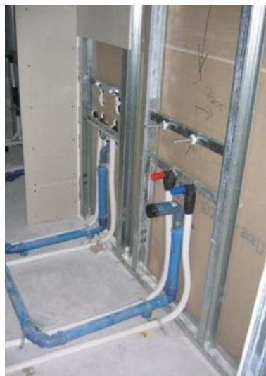
Fig. 6.50: Particolare passaggi impiantistici nelle intercapedini – Sistema IN.NOVA
