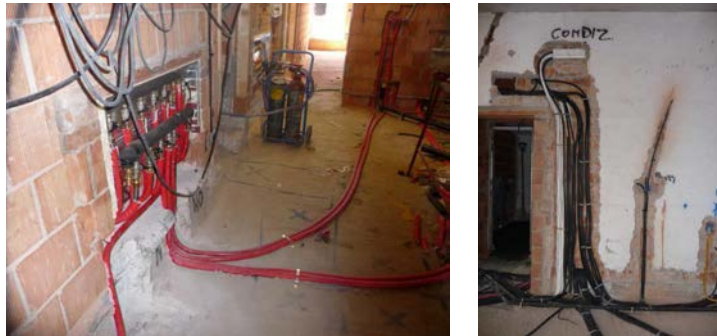
Fig. 6.52: Realizzazione di tracce e scatole per gli impianti – Sistema Tradizionale.
