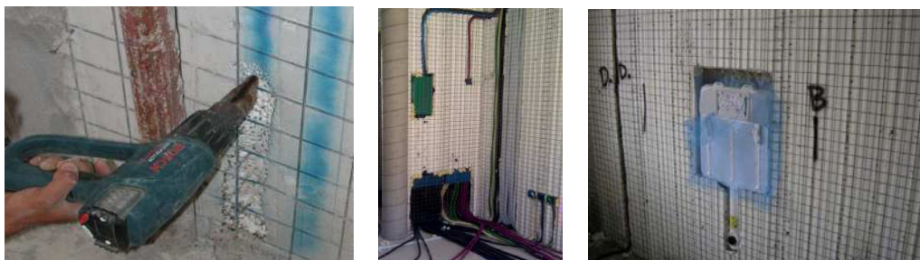
Fig. 6.51: Realizzazione delle tracce e delle scatole per gli impianti – Sistema Nidyon.
