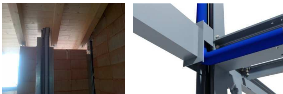
Fig. 6.49: Particolare passaggi impiantistici – Sistema IN.NOVA.
