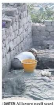
I CANTIERI Al lavoro negli scavi
