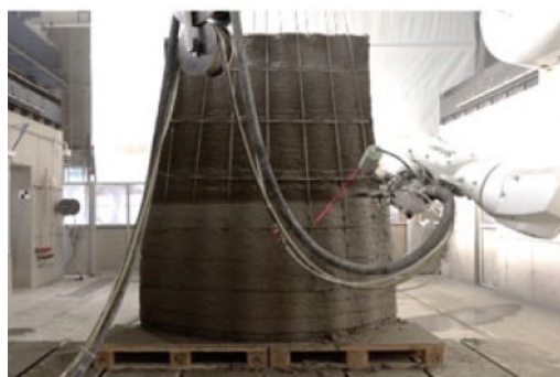
Figura 299. Shotcrete e implementazione delle armature nelle due direzioni (Buswell et al. 2022).
