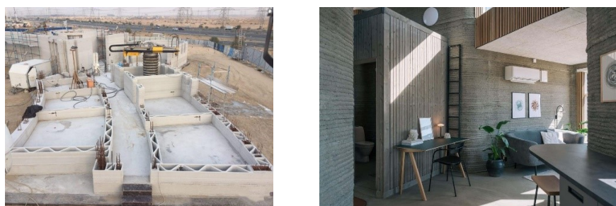
Figura 391. Dubai Office: sistema con casseri a perdere ottenuti tramite EP [17]; Holstebro House: finitura superficiale [11].
