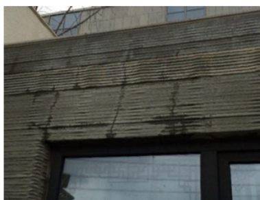
Figura 288. Fessurazione da ritiro precoce in pareti stampate in 3D (Buswell et al 2022)
