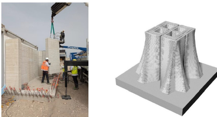
Figura 368. Fase di installazione dei pannelli stampati in 3D; Modello di un plinto di fondazione stampato in 3D (Capozzi et al. 2024).
