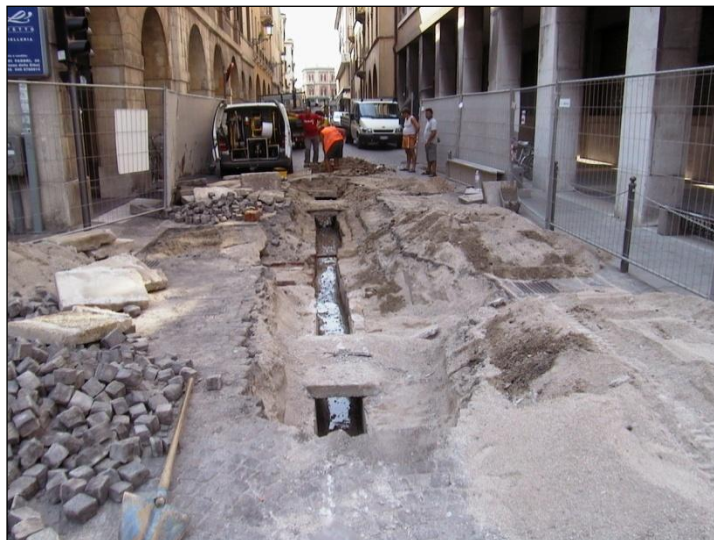
Figura 151: Canale di scolo al centro di via S. Francesco (Comune di Padova).
