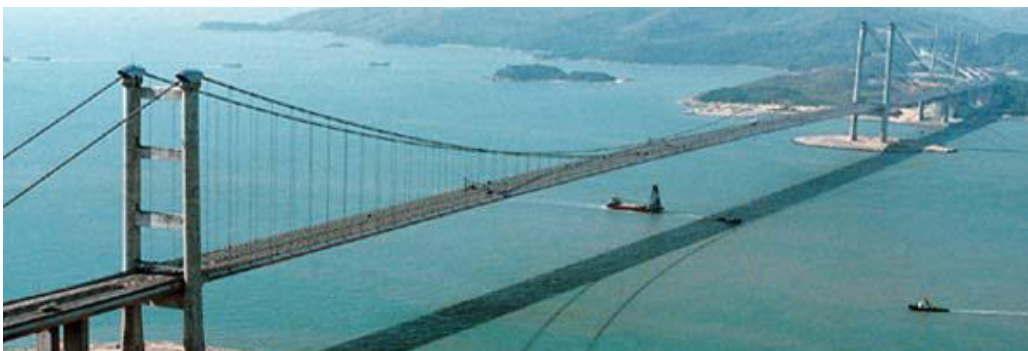
Figura 4: Il ponte Tsing Ma a Hong Kong, monitorato da 600 sensori (Farrar et al. , 1999).
