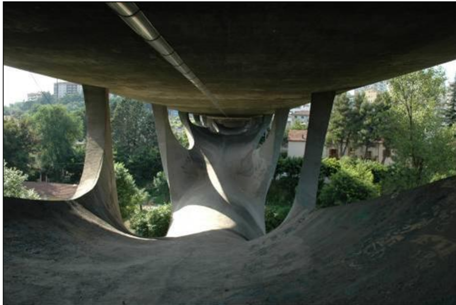
Figura 15: Il ponte Musmeci i provincia di Potenza (Proto et al, 2010).
