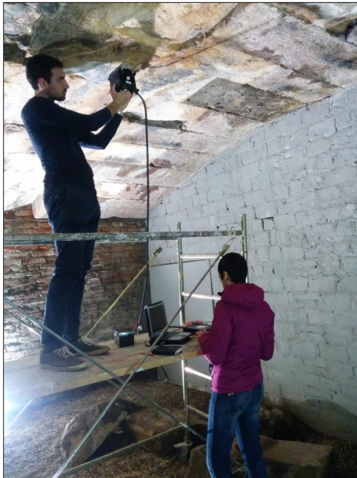
Figura 126: La misurazione georadar. Si nota l'impalcatura necessaria per raggiungere l'intradosso del ponte.
