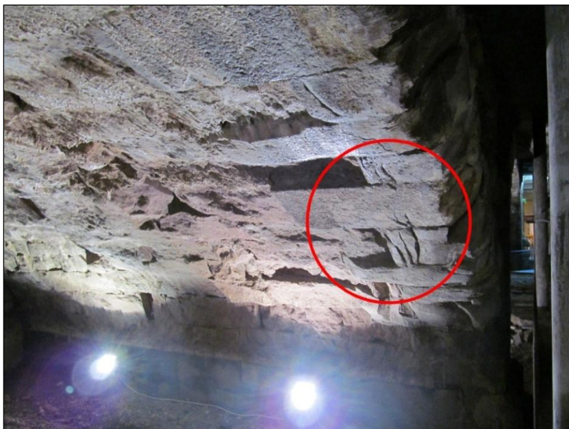
Figura 69: Fratturazione sull'archivolto della terza arcata.
