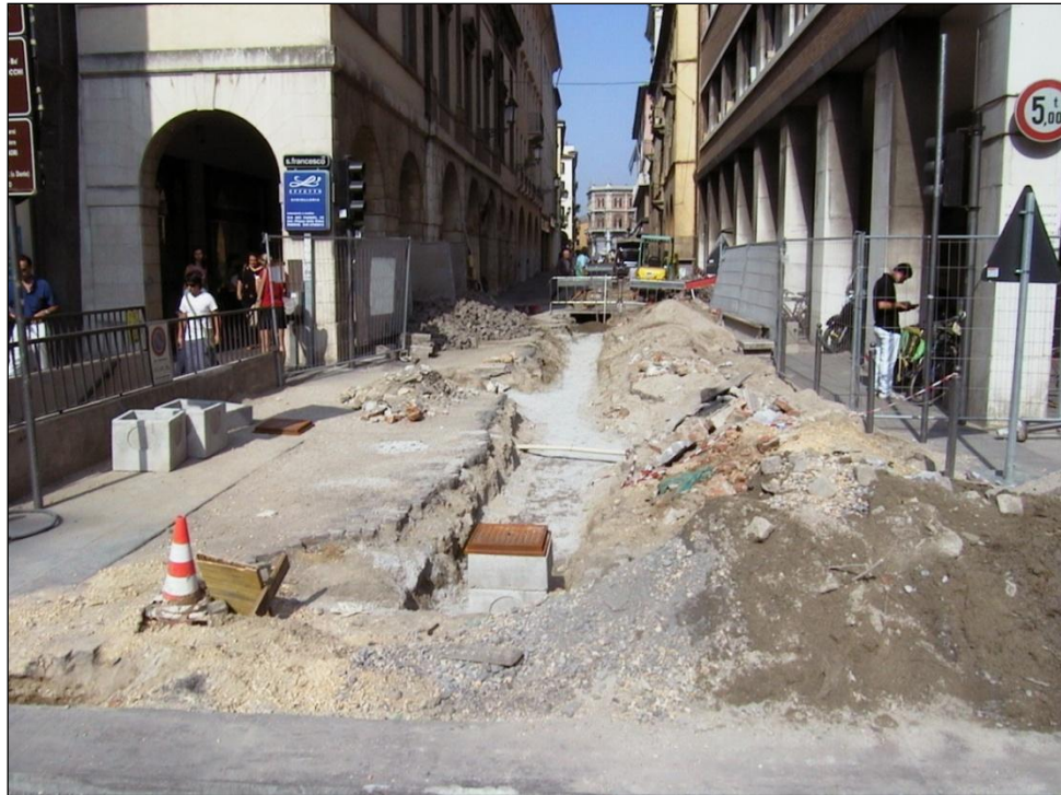
Figura 139: Rifacimento pavimentazione su via S. Francesco sull'estradosso del ponte. (Comune di Padova).
