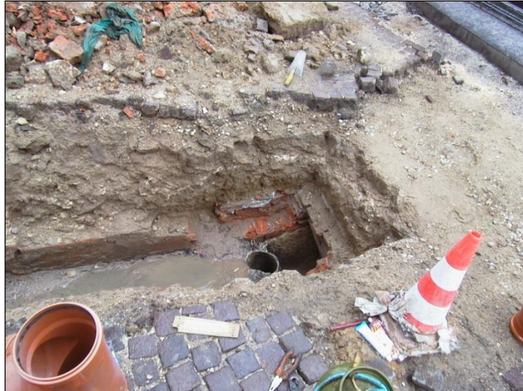
Figura 141: Particolare del canale di scolo al centro di via S. Francesco. (Comune di Padova).
