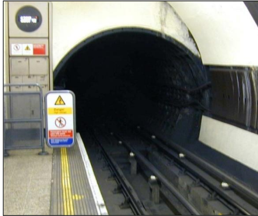
Figura 11: Il tunnel della Bakerloo Line alla stazione di Baker Street, Londra, dove sono avvenute le misurazioni (Degrande et al. , 2006).
