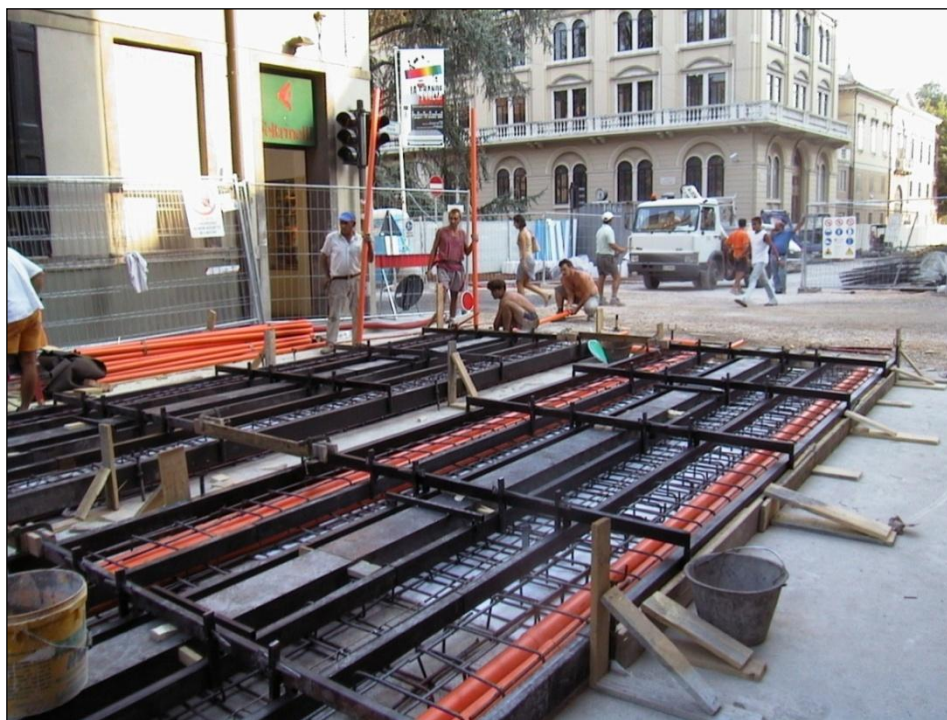
Figura 138: Getto della soletta in C.A. per la costruzione della linea tramviaria (Comune di Padova).
