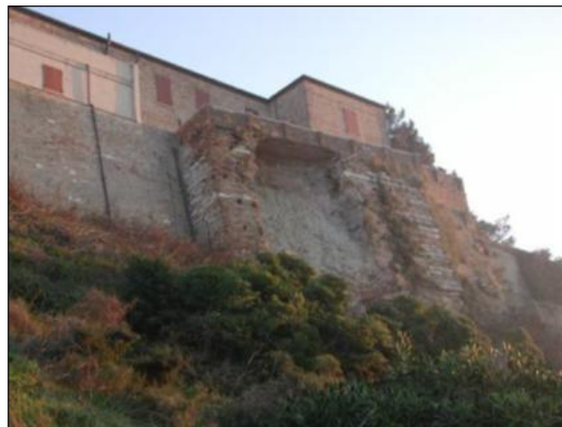
Figura 16: La muraglia oggetto di indagine ad Ancona (Del Conte e Esposito, 2006).
