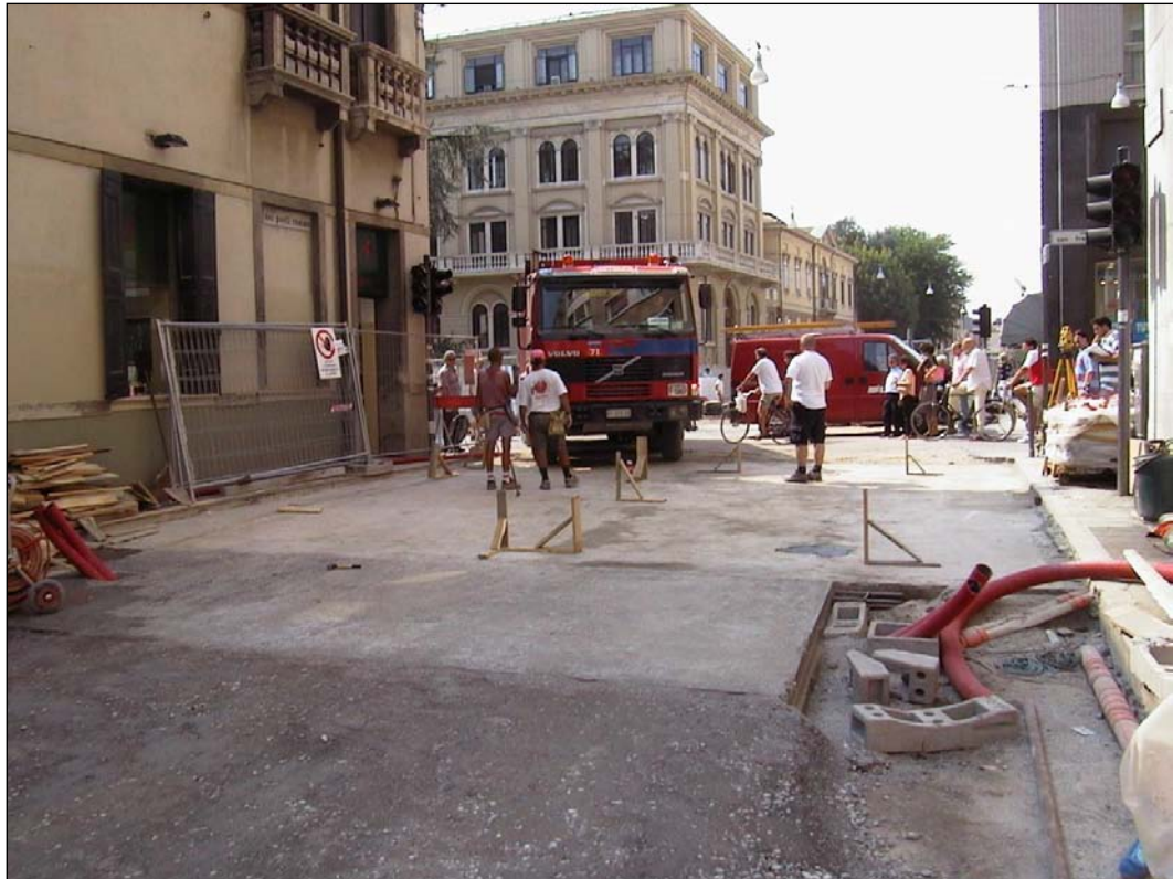
Figura 99: Stesura del manto stradale (Comune di Padova).
