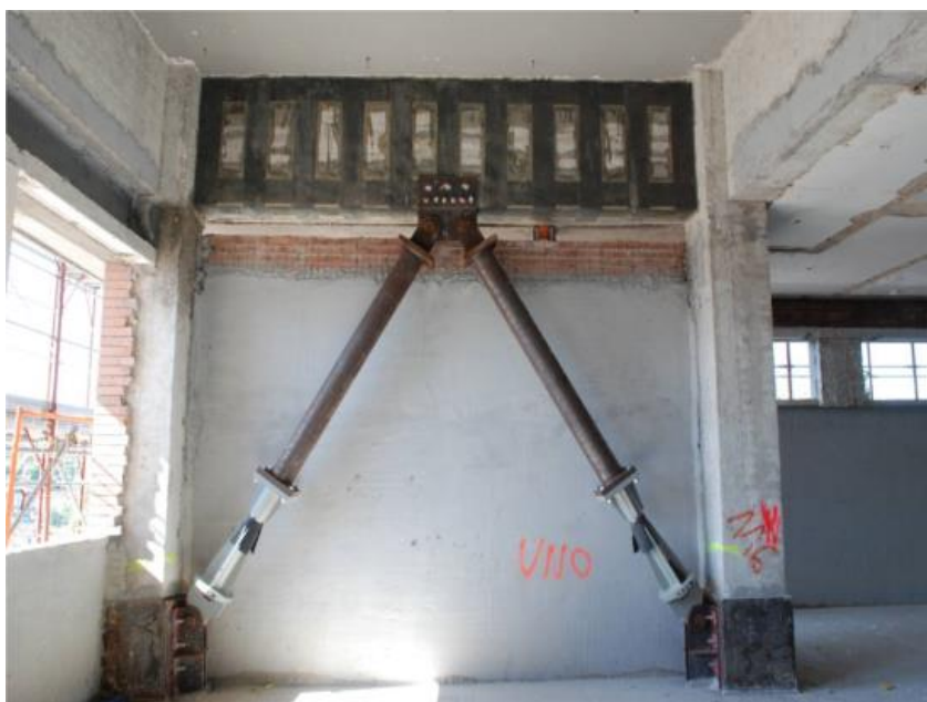
Figura 8.2. Esempio di controvento dissipativo BRAD
