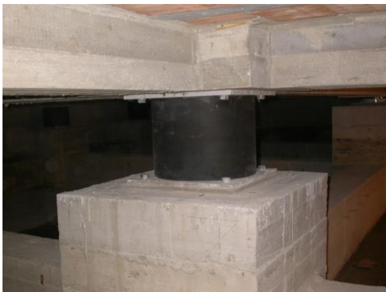
Figura 8.1. Esempio di isolatore sismico elastomerico
