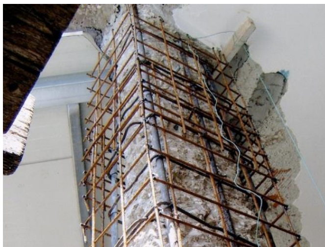
Figura 8.4. Esempio di incamicatura con calcestruzzo armato
