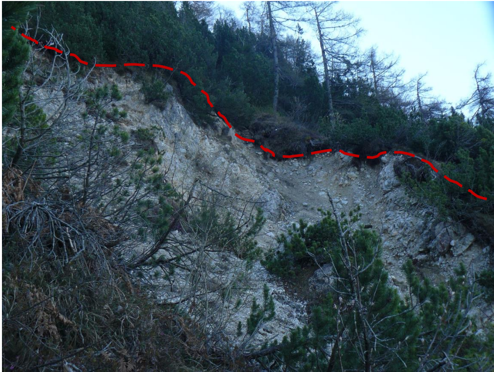
Figura 21: Coronamento della frana
