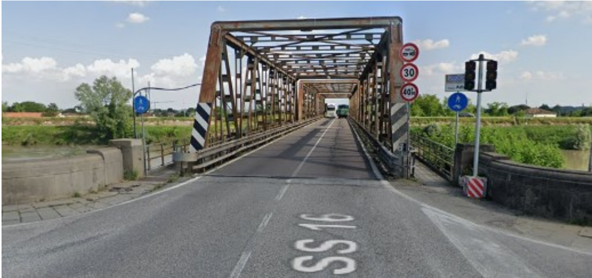
Figura 3.9 - Zoom del "Ponte sull'Adige" Immagine tratta da "Street View, Google Maps"
