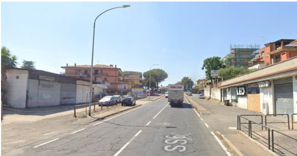
Figura 3.12 – Esempio di tratto stradale tra le chilometriche 17 e 19
