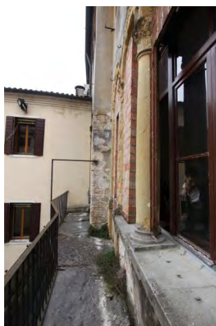
Figura 4.19 Balcone della facciata Nord
