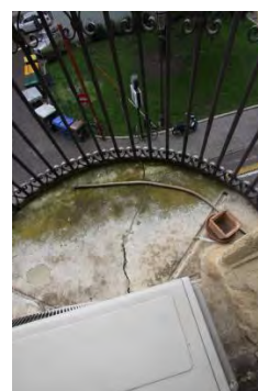
Figura 4.17 Balcone su via S. Francesco
