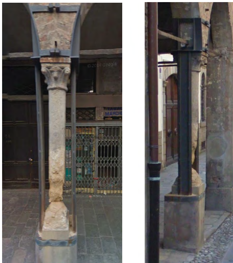
Figura 8.10 Esempio applicativo puntelli in acciaio, Via Vescovado 71 Padova
