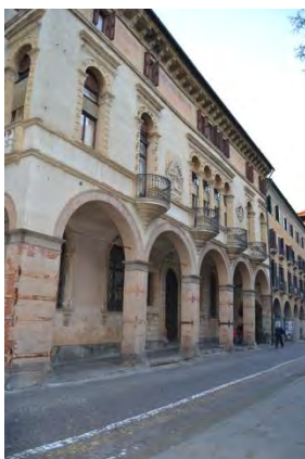
Figura 4.16 Facciata principale su via S. Francesco
