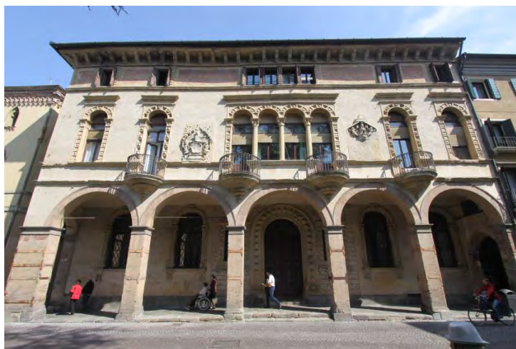
Figura 2.1 Facciata principale su via S. Francesco
