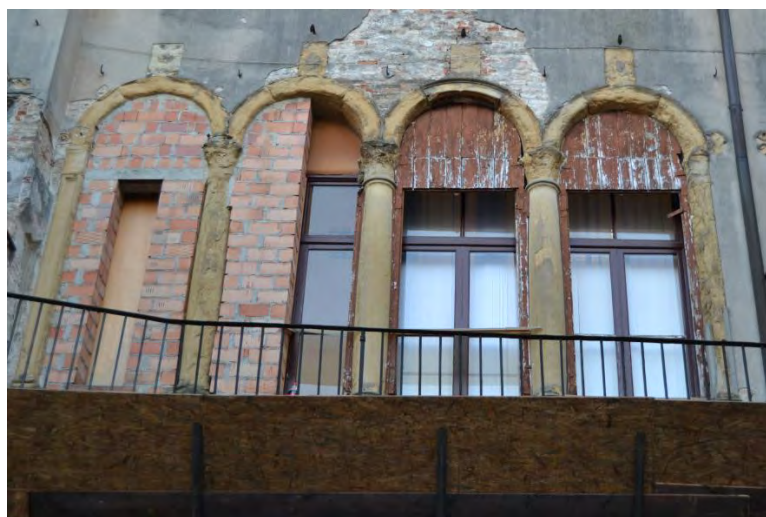
Figura 8.16 Tamponatura della terza e quarta arcata
