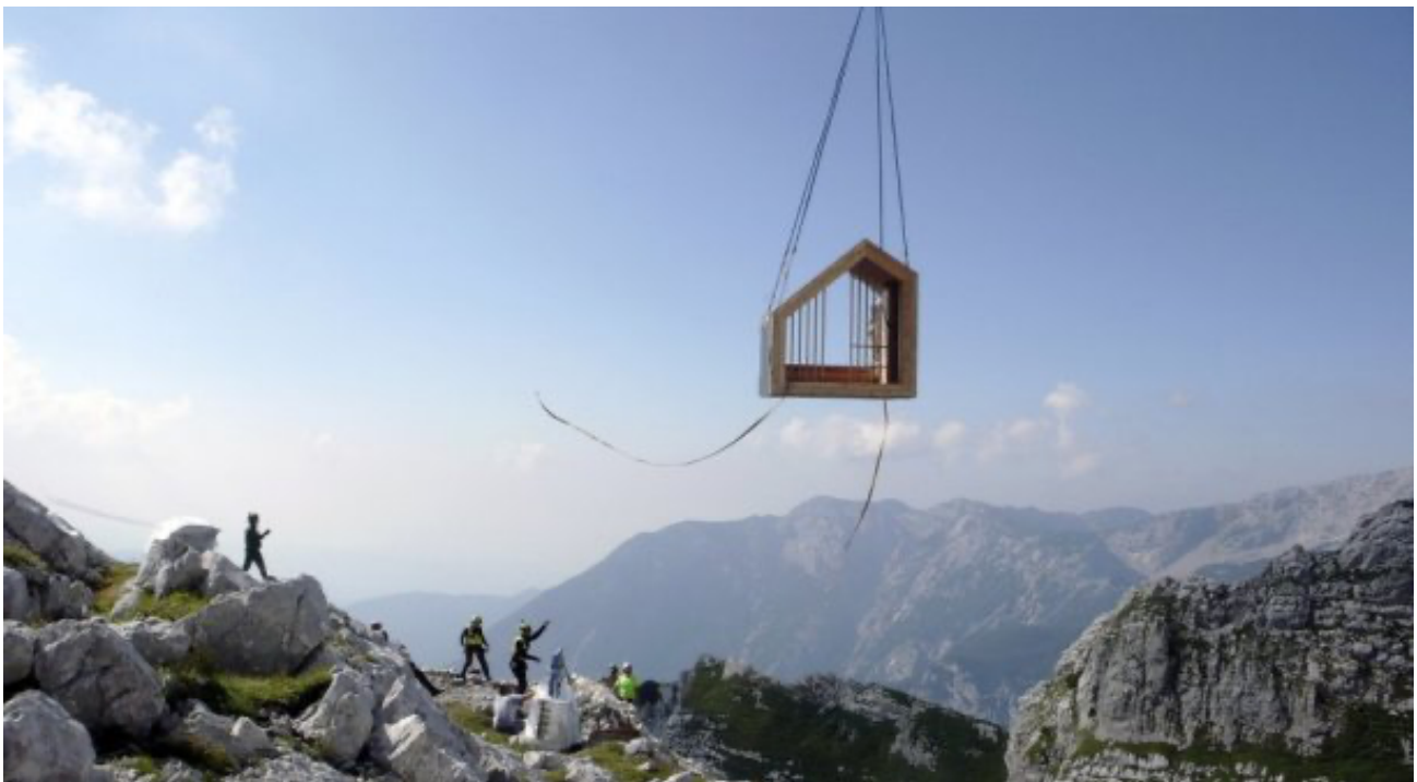
Figura 37: Trasporto dei moduli tramite elicottero [Fonte: Rifugio alpino s Skuta: https://www.domusweb.it/it/architettura/2015/09/16/ofis_architects_e_akt_ii_alpine_shelter_skuta.html , (Accesso: 28 febbraio 2022)]
