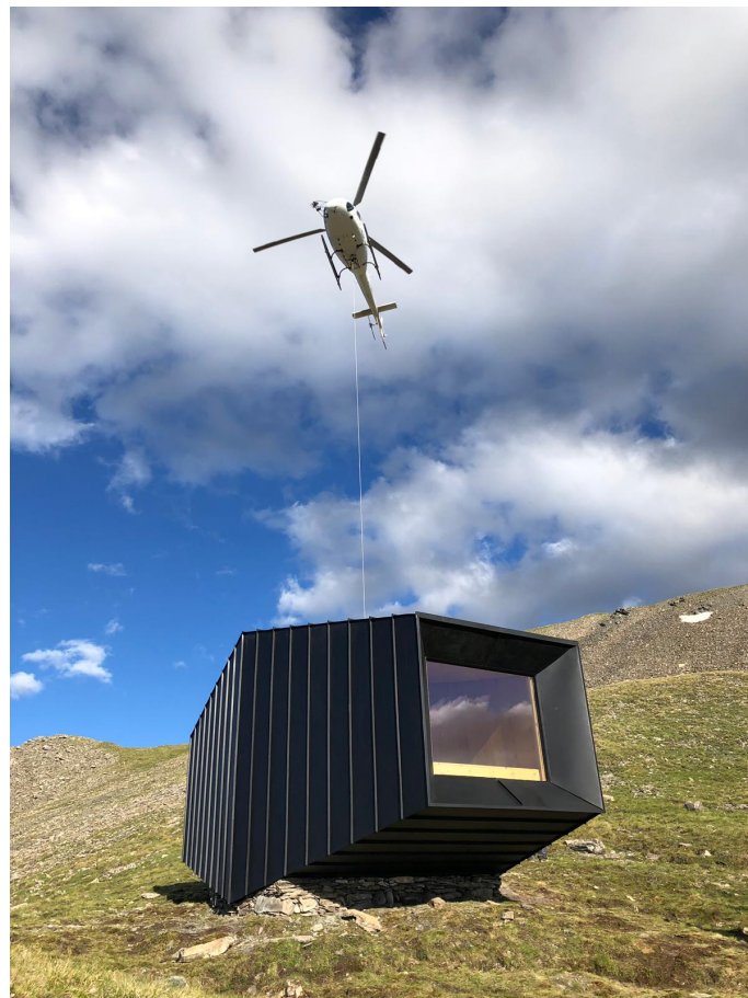
Figura 13: Trasporto di un bivacco nel luogo designato tramite elicottero [Fonte: Abitare, strutture e case in legno, Sostenibilità in quota , https://abitarelegno.com/3409-2/ , (Accesso: 17 febbraio 2022)]
