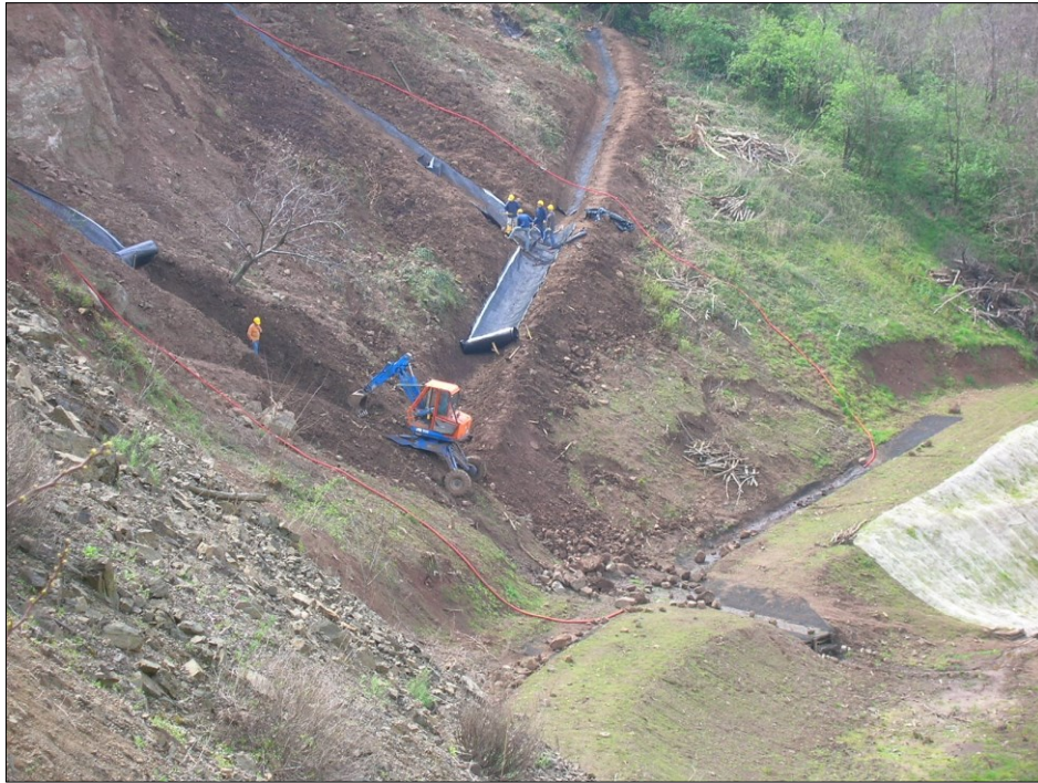
Figura 2.13: operazioni di posa delle canalette di drenaggio superficiale (Archivi dei Servizi Forestali Regionali del Veneto).
