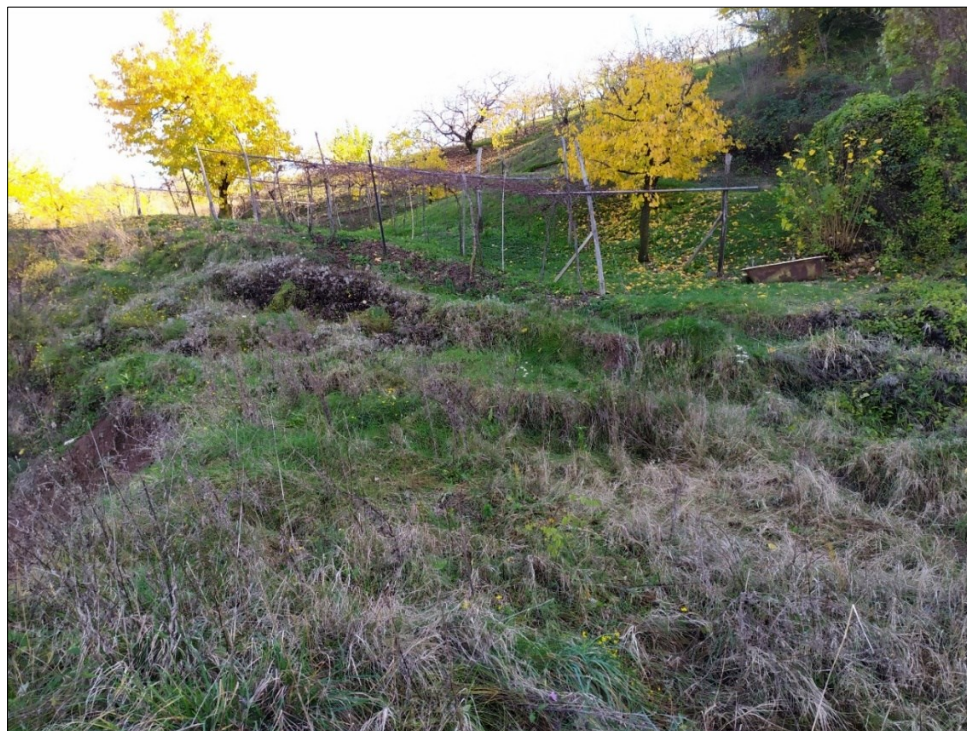
Figura 2.4: gradini e fessurazioni superficiali osservabili in sito.
