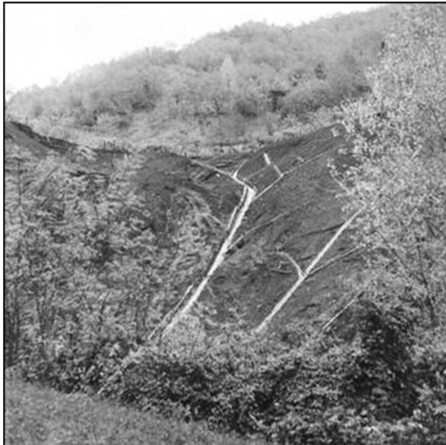
Figura 2.6: rete di drenaggio superficiale realizzata negli anni '50 (Archivi dei Servizi Forestali Regionali del Veneto).
