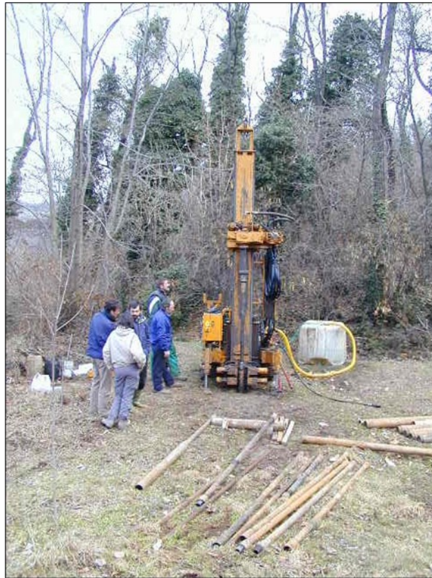
Figura 2.8: esecuzione dei sondaggi piezometrici sul corpo di frana (Archivi dei Servizi Forestali Regionali del Veneto).
