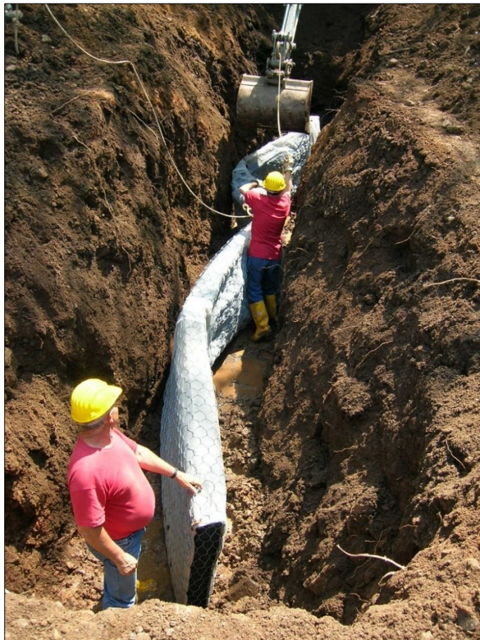
Figura 2.14: operazioni di posa della trincea drenante sub-alveo nell'intervento di sistemazione del 2007 (Archivi dei Servizi Forestali Regionali del Veneto).
