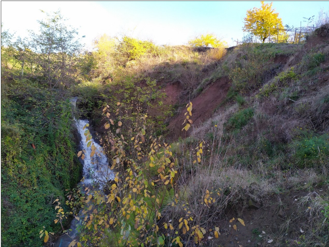
Figura 4.1: erosione spondale nella zona della cascata allo stato attuale.
