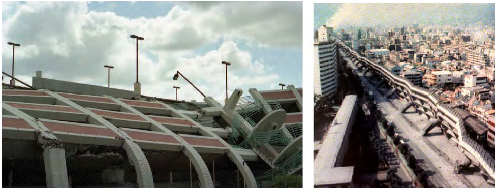
Figura 1.1: Danni dovuti ai terremoti di Northridge, a sinistra, e Kobe, a destra.
