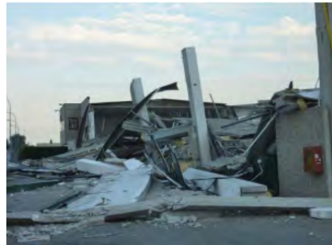
Figura 1.4: Esempi di danni ai pilastri
