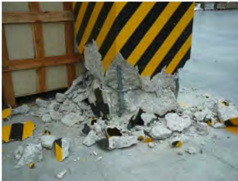
Figura 1.4: Esempi di danni ai pilastri
