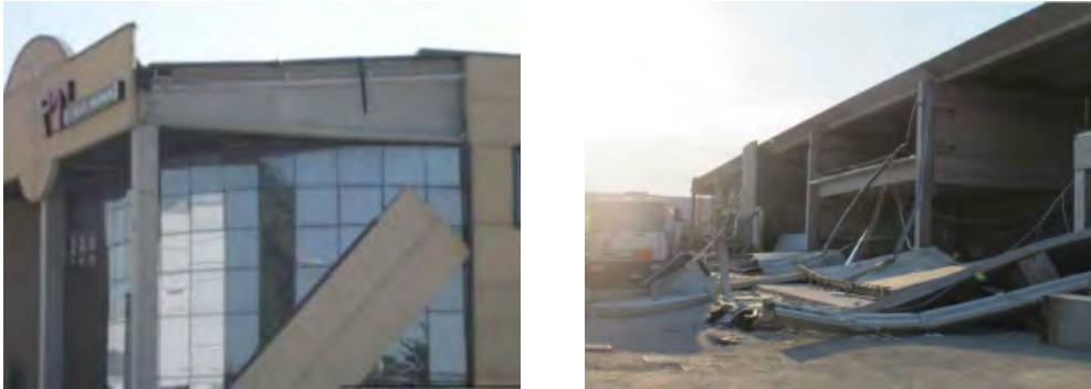
Figura 1.2: Esempi di collasso dei pannelli
