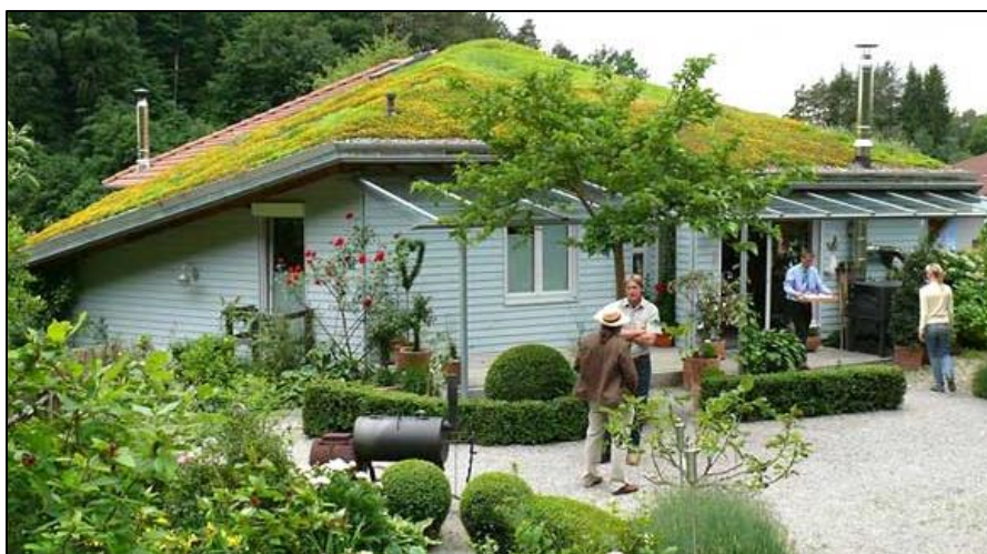
Fig. 1.6 Esempio di verde pensile realizzato con il metodo del "mattone erboso" ( http://www.prefabbricatisulweb.it/ )
