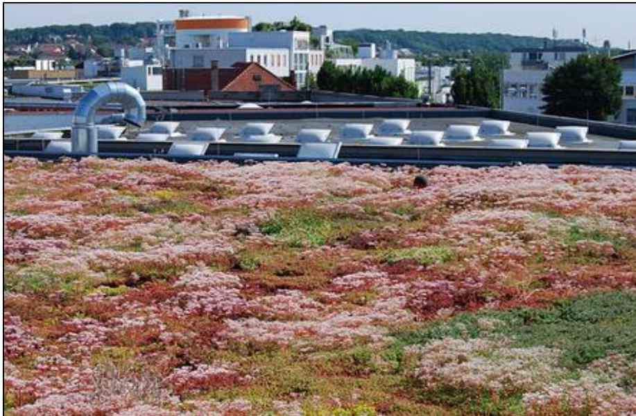
Fig. 2.1 Esempio di tetto verde estensivo ( http://www.bauder.it/ )
