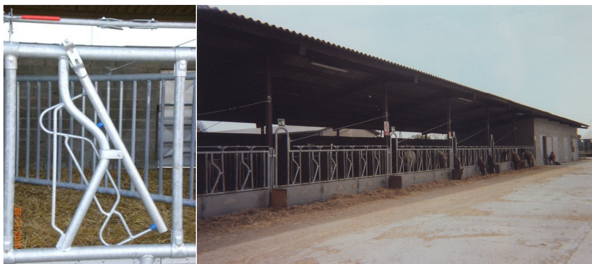
Figura 7. Autocattura, antisoffoco e box multipli dove erano collocati i puledri.
