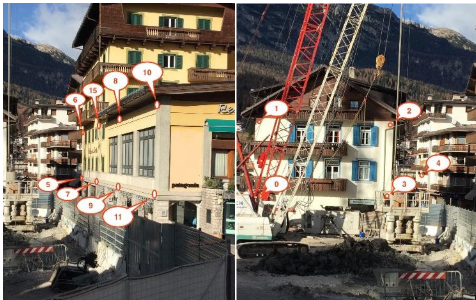
(Fig. 4.10) Immagini raffiguranti gli edifici in cui sono stati posizionati alcuni dei punti di misura (rispettivamente Hotel San Marco e Casa Ghedina)
