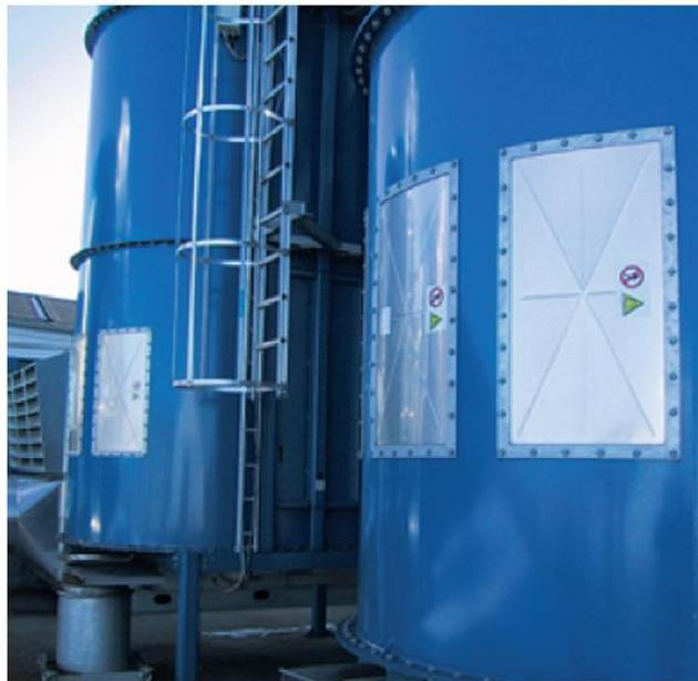
Figura 16: pannelli di rottura
